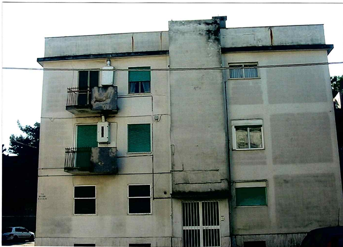
BRINDISI VIA MASSIMO D'AZEGLIO CIV. 1 PROSPETTO PRINCIPALE
