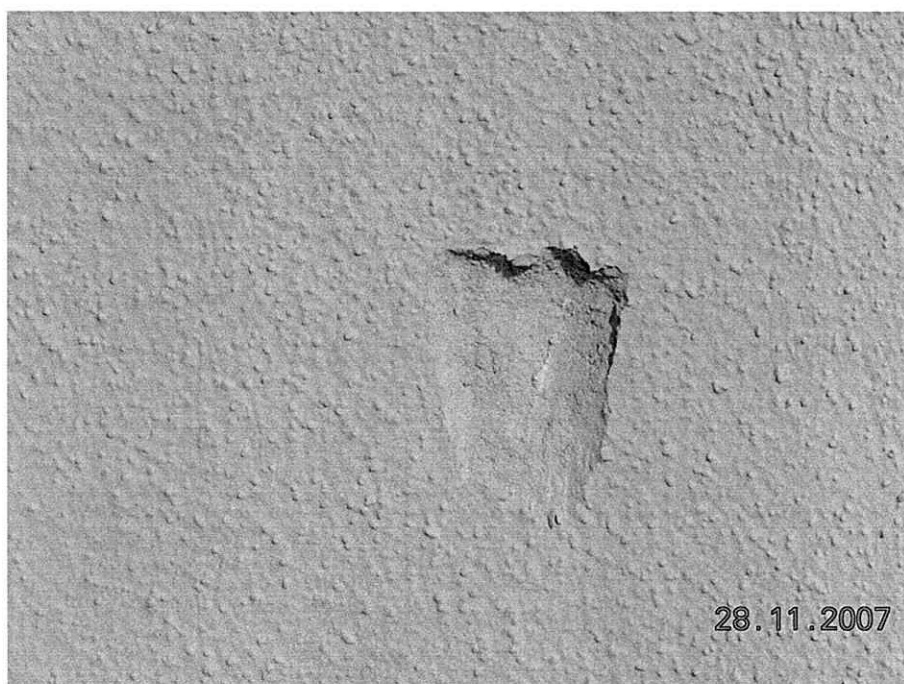
Fotografia 4: prospetto SUD – particolare del saggio n. 1 sull'intonaco
