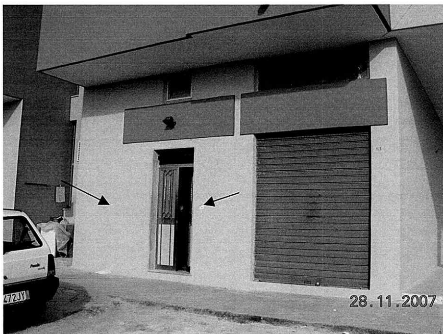
Fotografia 3: prospetto SUD – saggi sull'intonaco
