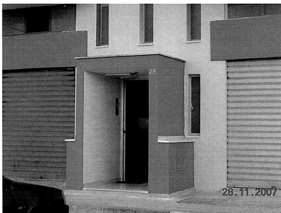
Fotografia 22: Prospetto NORD – particolare di un ingresso scala
