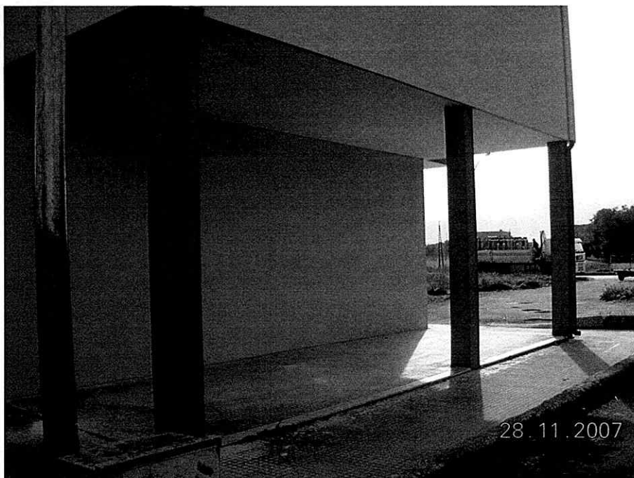
Fotografia 19: Prospetto OVEST - Particolare
