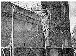
Andatoia in legno completa di parapetto e di listelli inchiodati sul piano inclinato.
