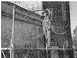
Livellamento con sabbia del piano di posa di un ponteggio.
