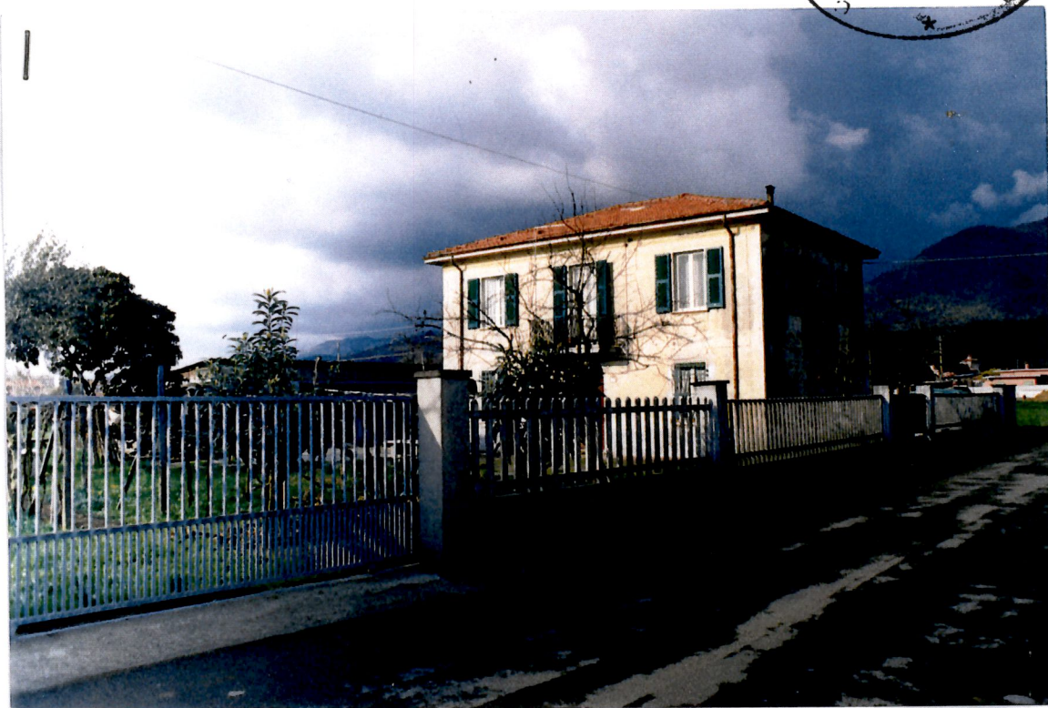
VISTA LATO SUD-EST
