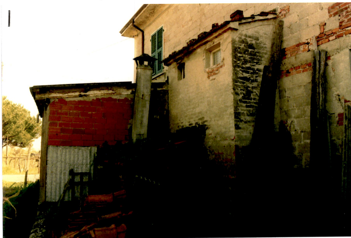
VISTA LATO NORD
