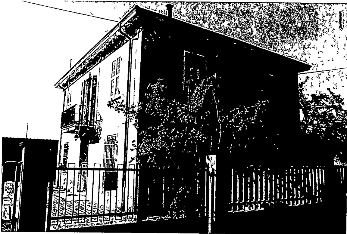
VISTA LATO SUD - EST
