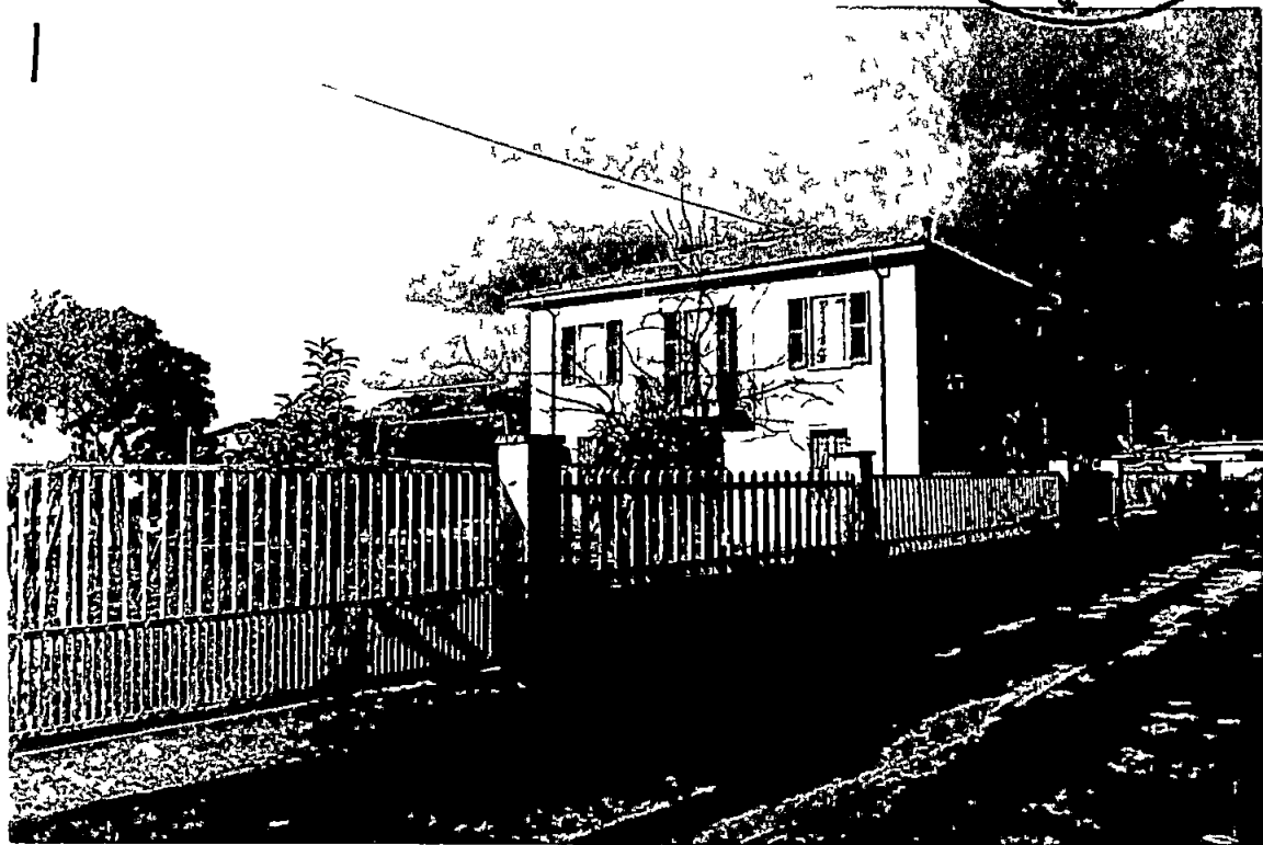
VISTA LATO SUD-EST
