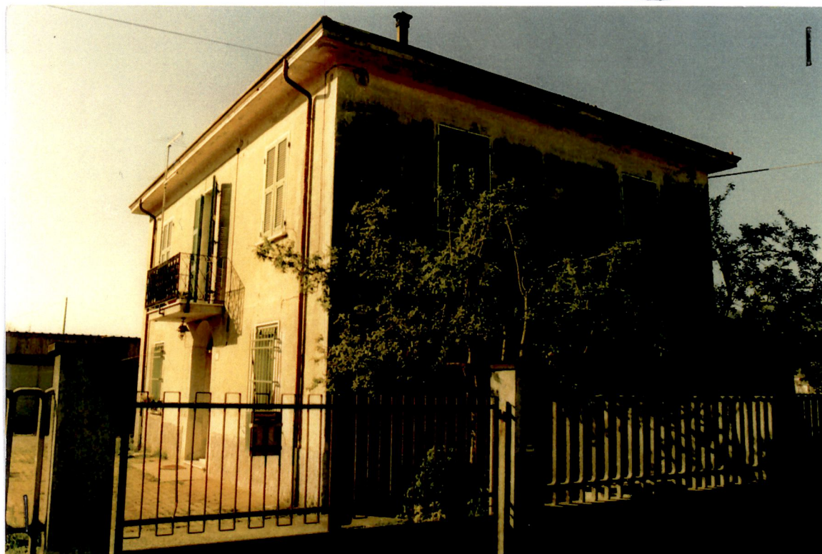
VISTA LATO SUD - EST
