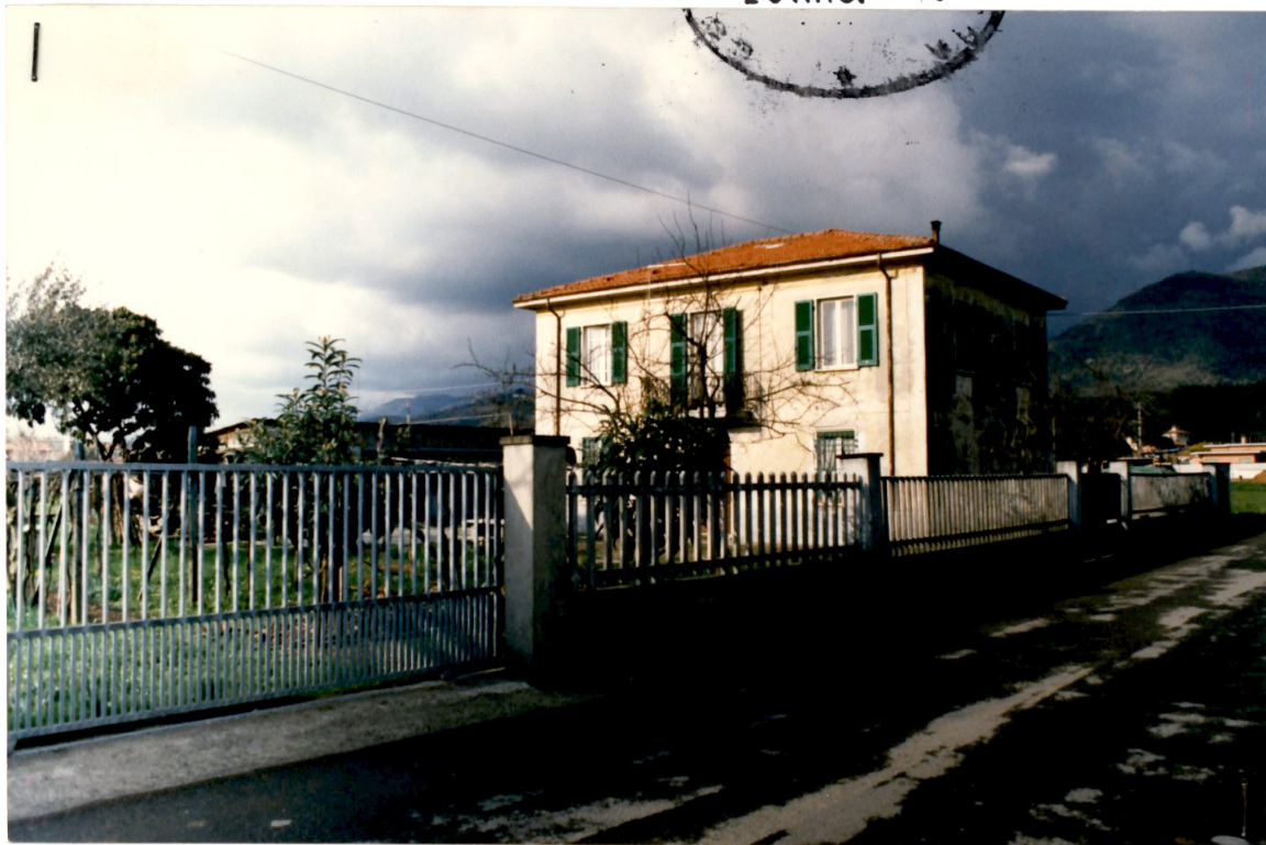
VISTA LATO SUD-EST
