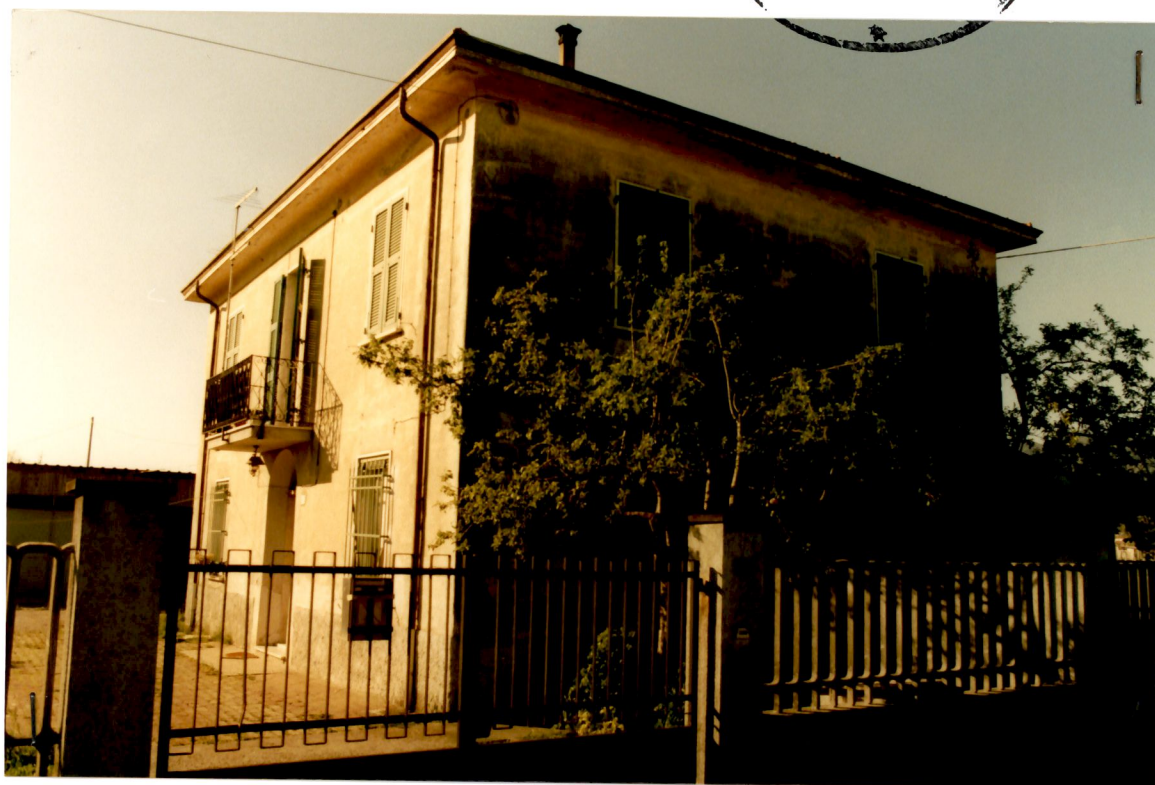
VISTA LATO SUD - EST
