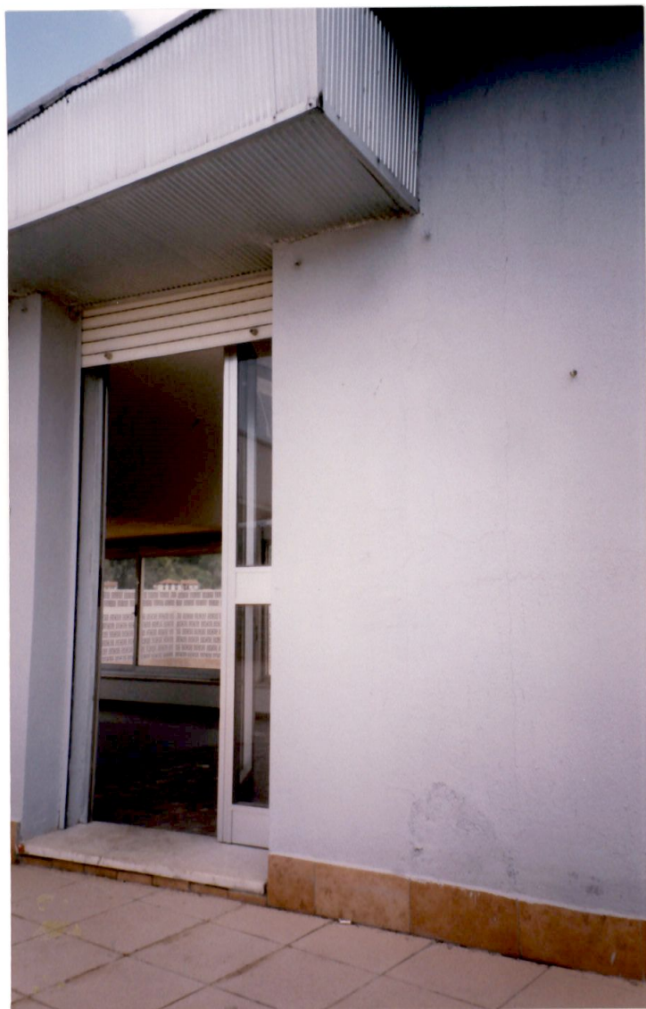
MANSARDA - SOSTITUZIONE SERRAMENTI e PANNELLI COPERTURA
