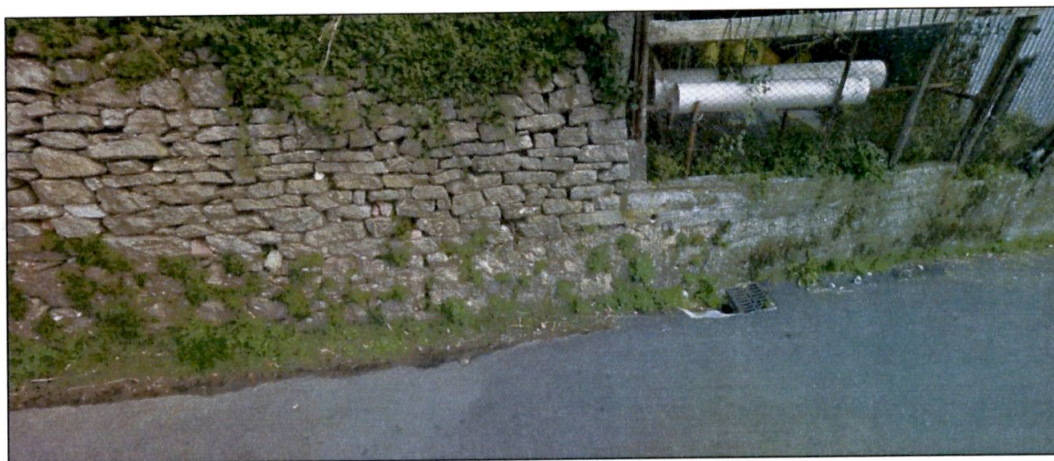
Figura n.14 - Griglia caditoia collegata a rete idrica bassa presente lungo la cunetta di monte della viabilità comunale Via C.Cafiero, ubicata appena a valle dell'attuale muro di contenimento in pietrame, oggetto di interventi di demolizione e ricostruzione.
