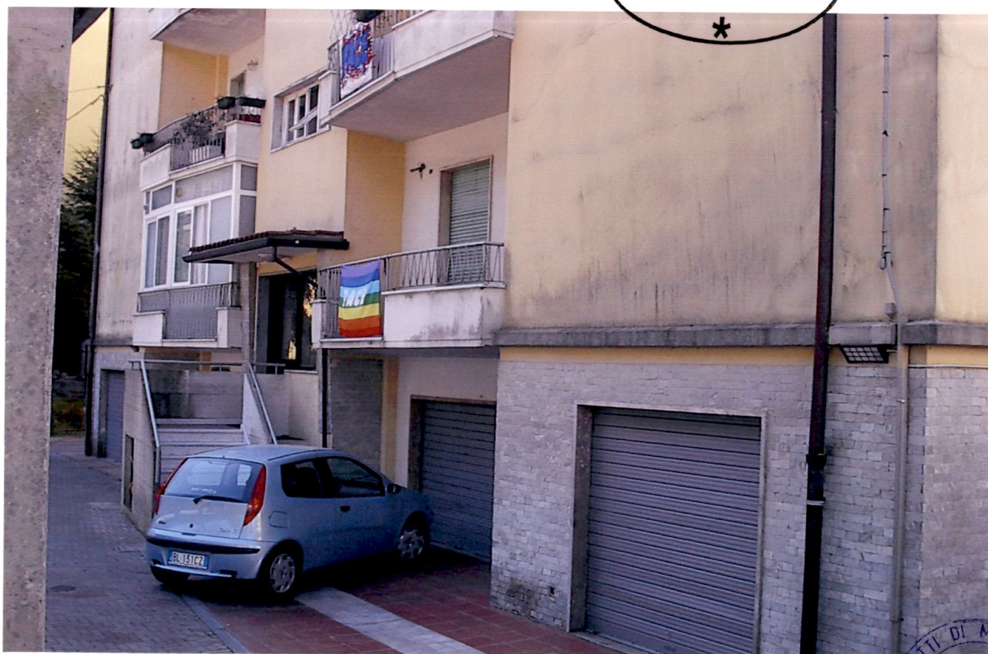
PARTICOLARE INGRESSO CONDOMINIALE
