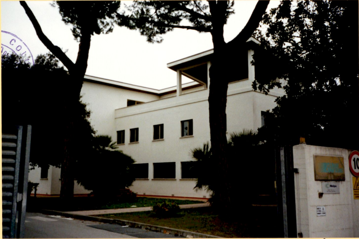
Foto 1 - LATO INGRESSO (VIALE ZACCAGNA)
