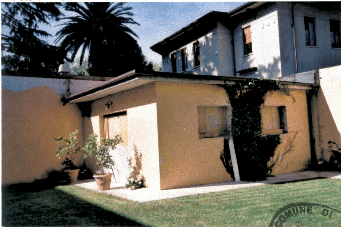
Foto 1 – Vista dei due fronti del fabbricato.
