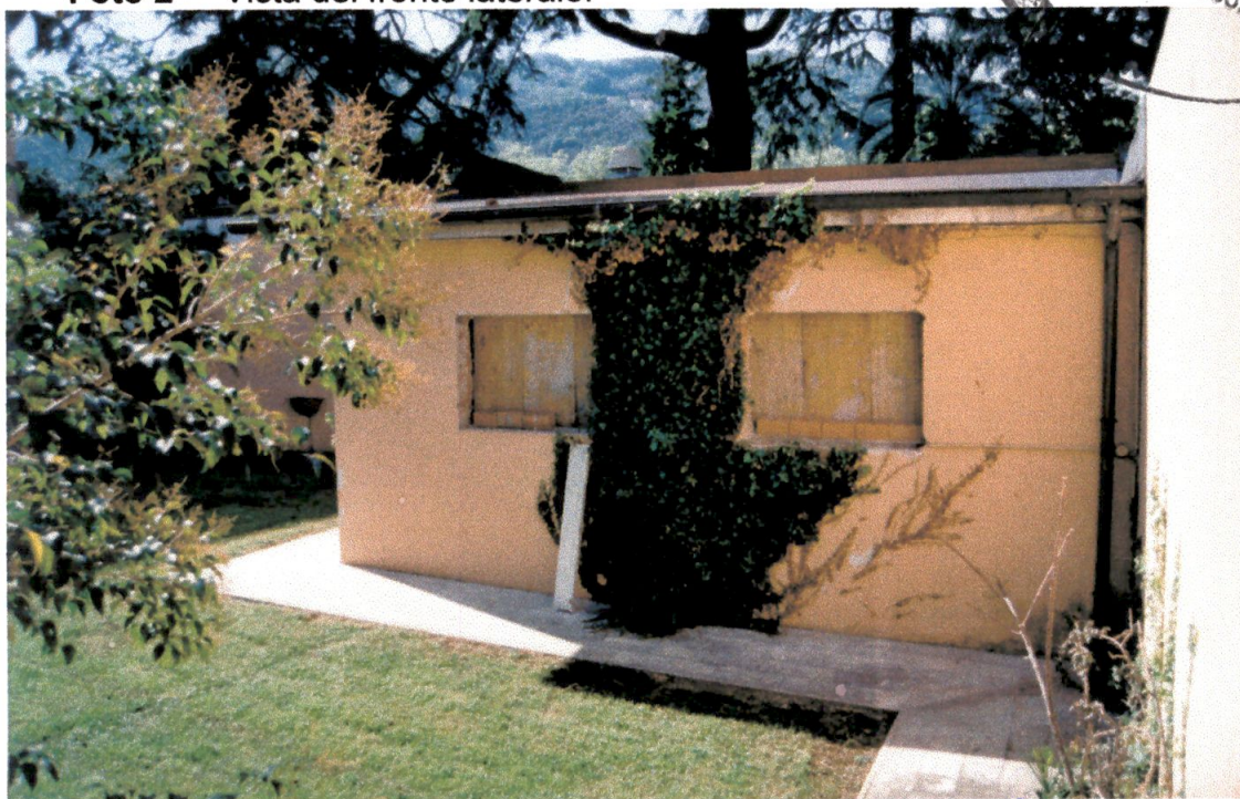
Foto 2 – Vista del fronte laterale.
