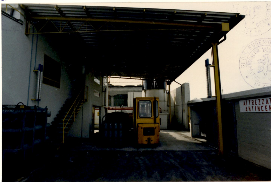
REP. ACETILENE - TETTOIA LATO SPEZIA
