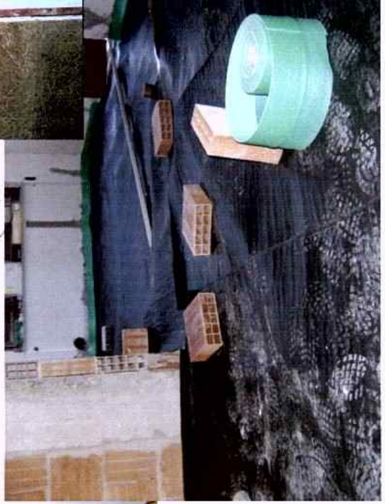
Foto in corso d'opera - posa di tappeto fonoassorbente
