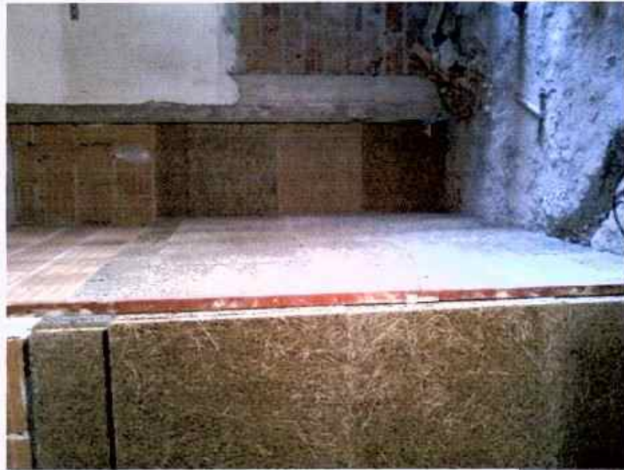
Foto in corso d'opera - creazione parete divisoria, con utilizzo di pannello isolante termo- acustico Celenit
