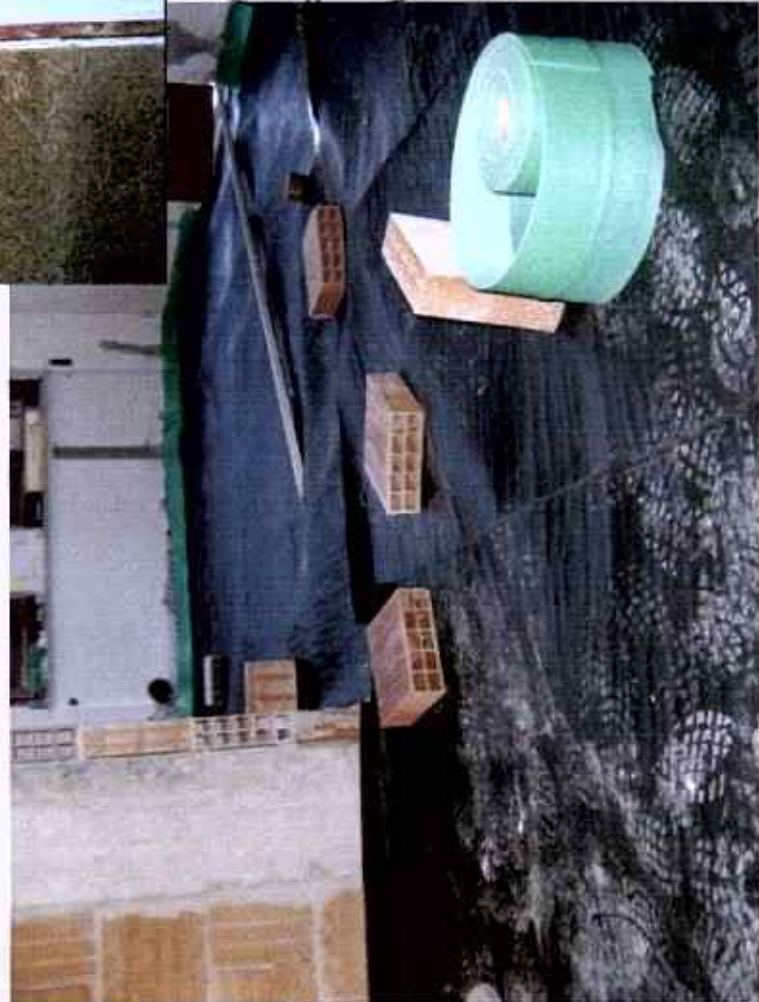
Foto in corso d'opera - posa di tappeto fonoassorbente
