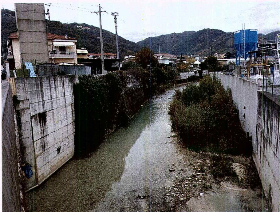
Fig. 5 – Ripresa fotografica dal ponte su Via Piave lato monte – Data: 23/11/2016
