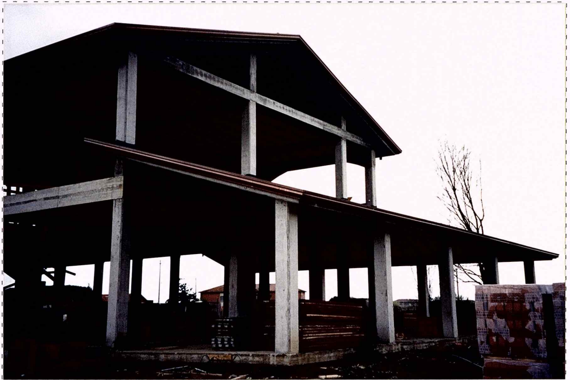
foto prospetto nord-est
