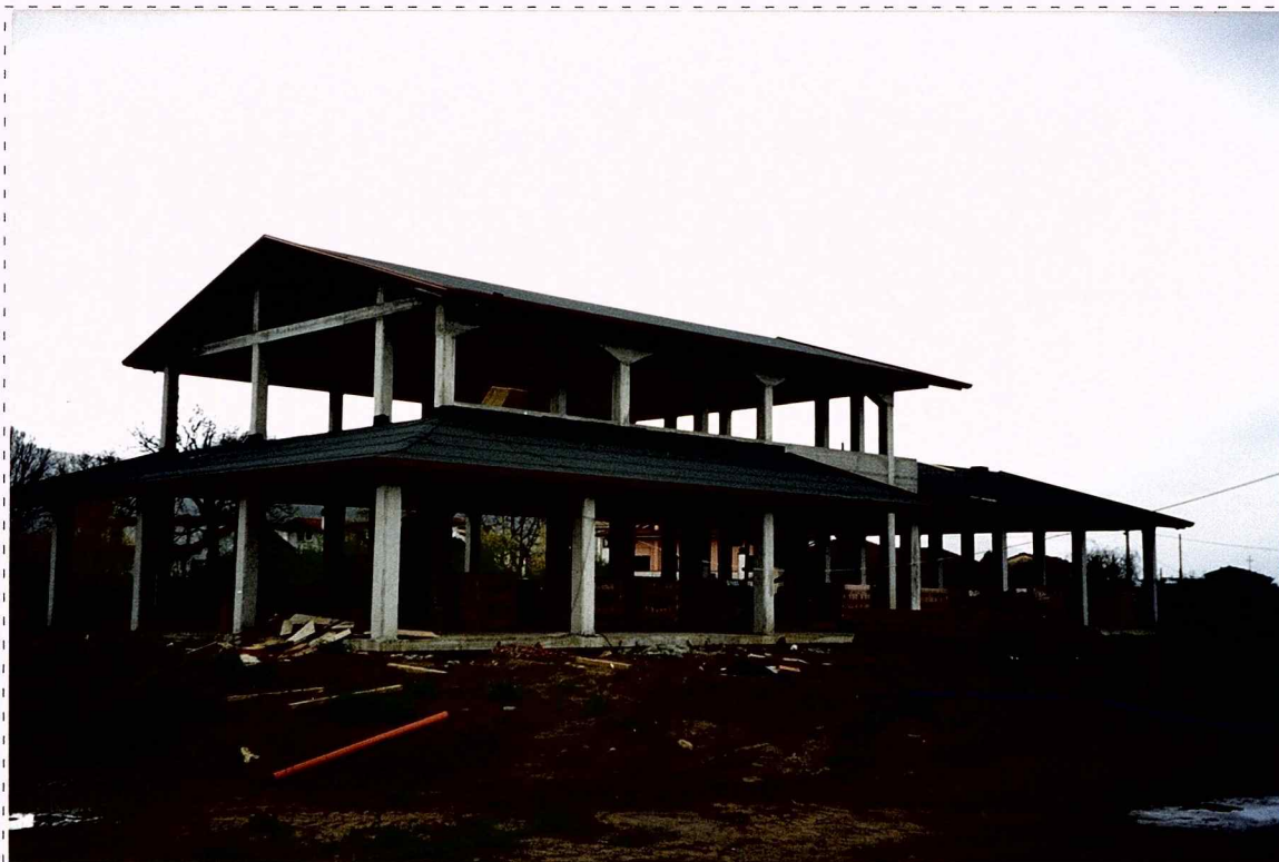
foto prospetto sud
