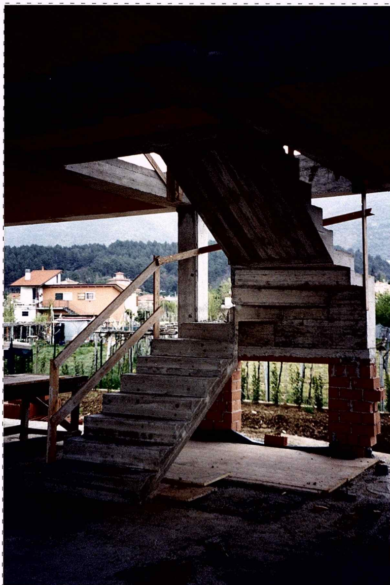
foto scala interna residenza
