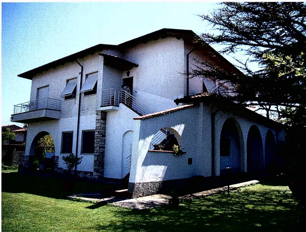
Vista esterna fabbricato fronte anteriore
