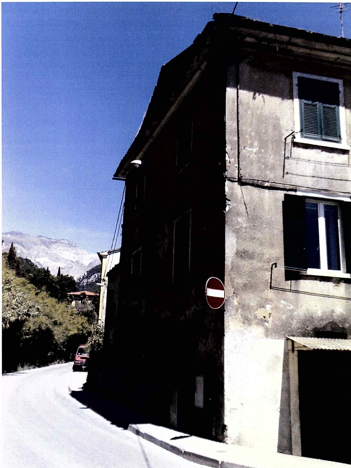
Foto 2 – Vista del prospetto laterale da via Carriona
