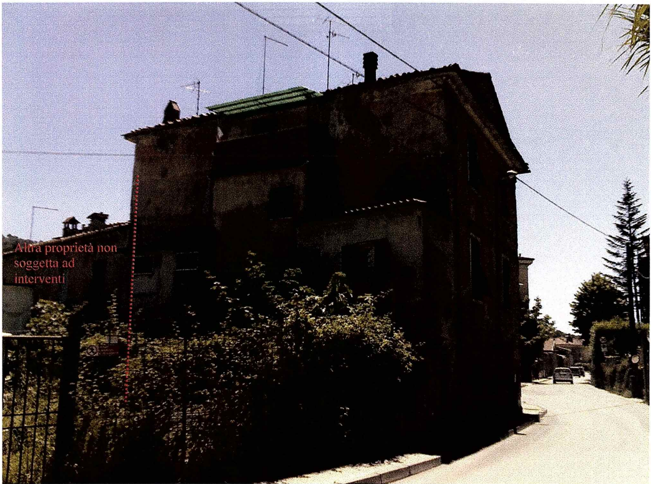
Foto 3 – Vista da via Carriona del prospetto retrostante.
