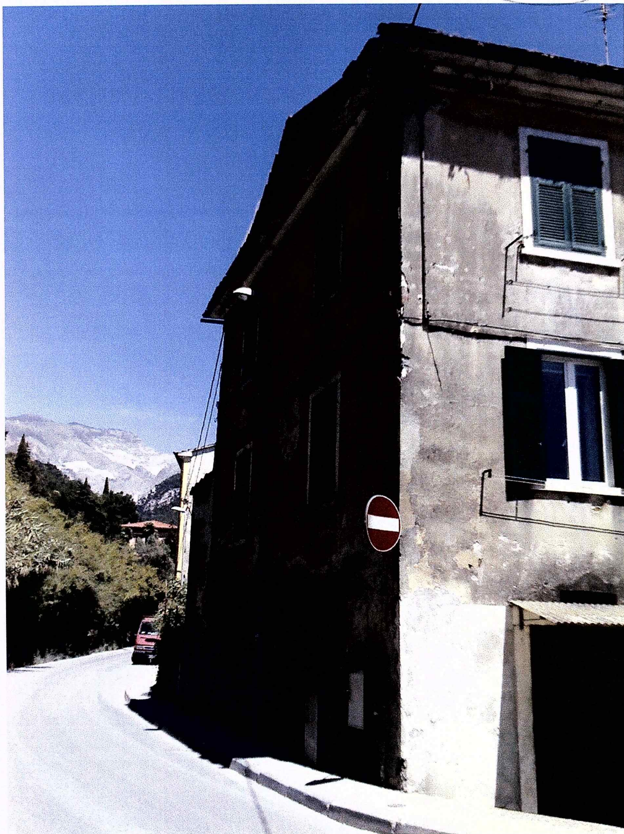
Foto 2 – Vista del prospetto laterale da via Carriona
