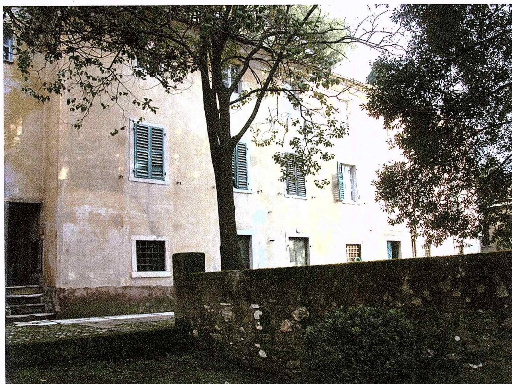
foto n.3, veduta prospetto su cortile interno
