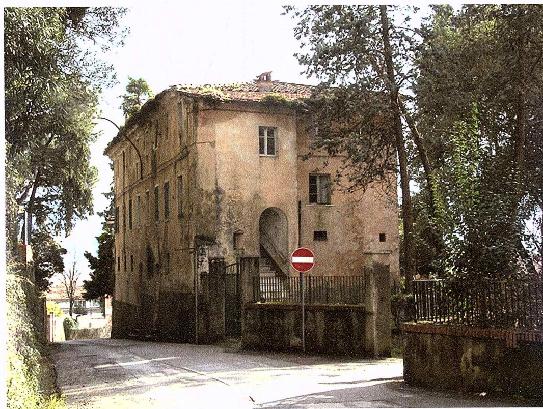
foto n.1, veduta prospetto laterale
