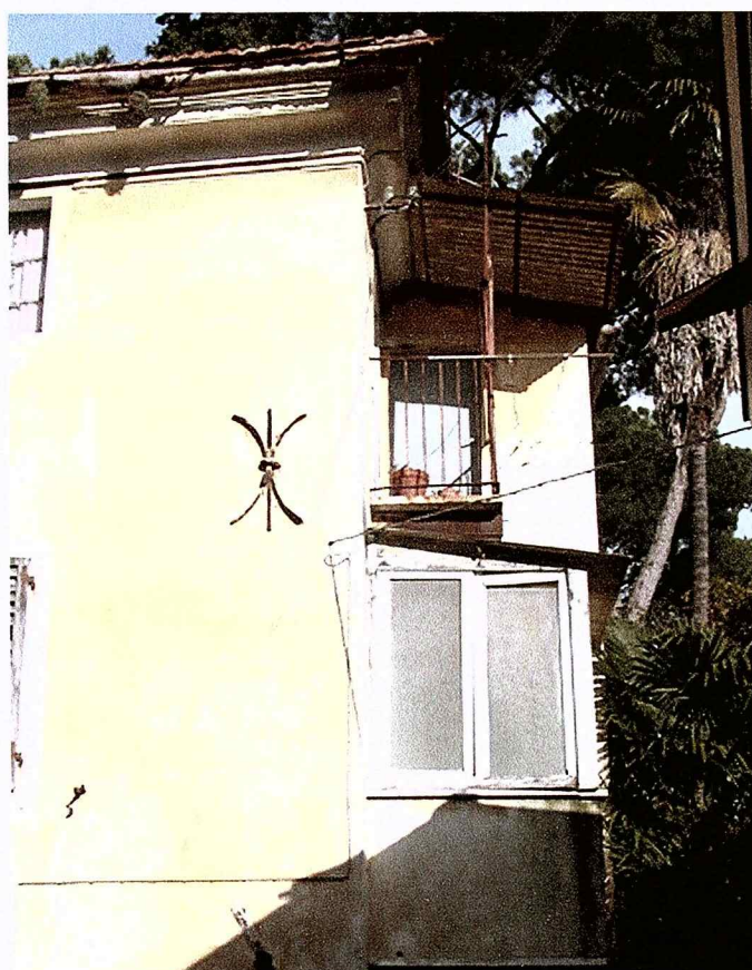
foto n.5, particolare prospetto su cortile interno
