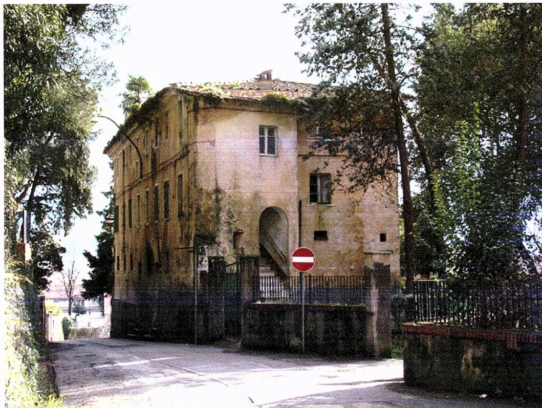
foto n.1, veduta prospetto laterale
