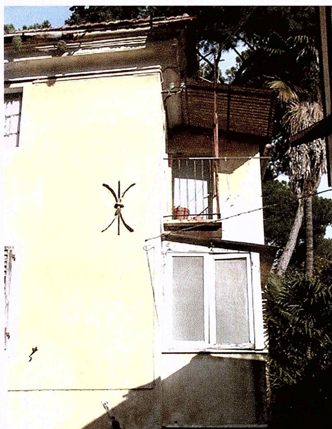
foto n.5, particolare prospetto su cortile interno
