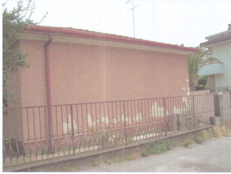
Foto 2 - PROSPETTO LATO SARZANA
