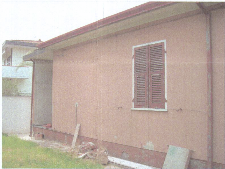
Foto 4 - PROSPETTO LATO MASSA
