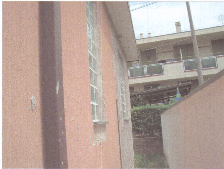
Foto 3 - PROSPETTO LATO MARE
