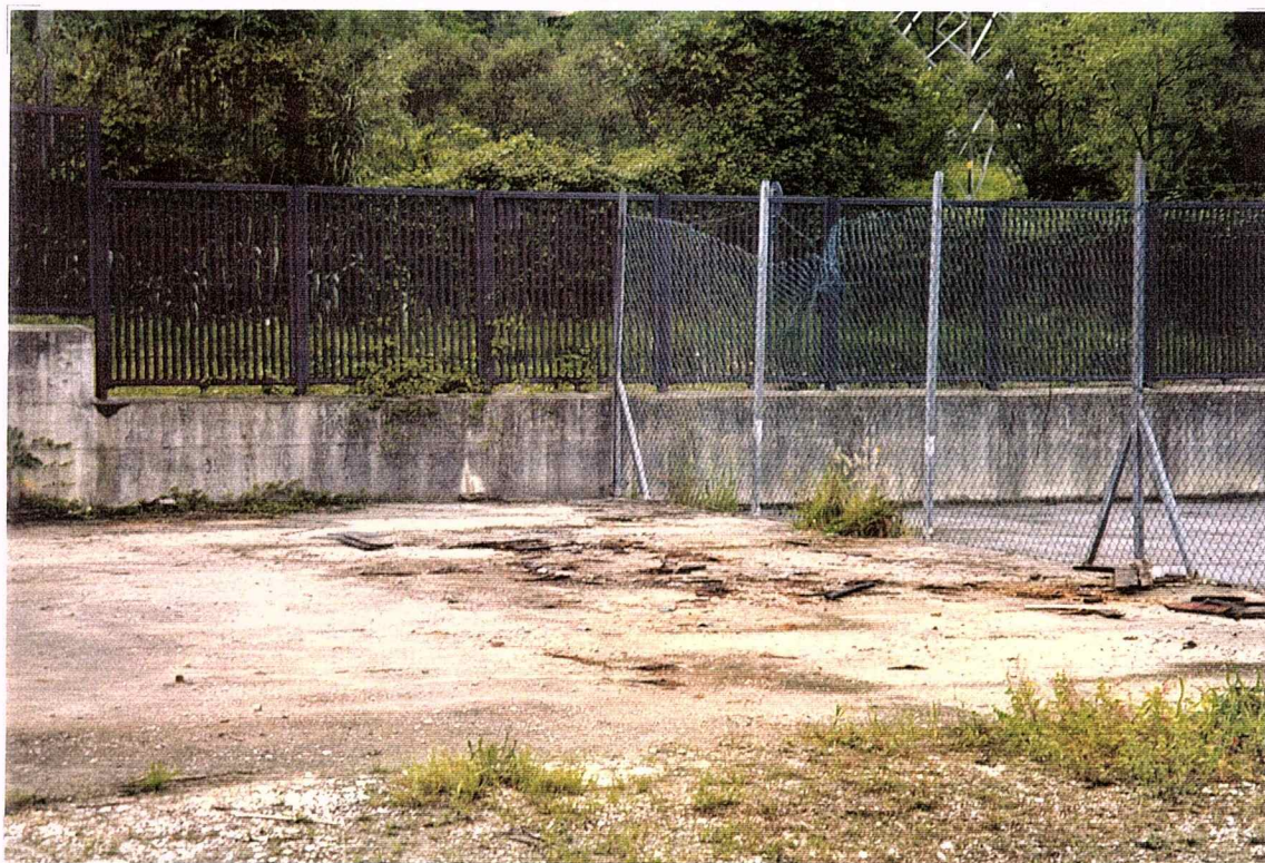
AREA ALLOGGIO SHELTER - RECINZIONE INTERNA
