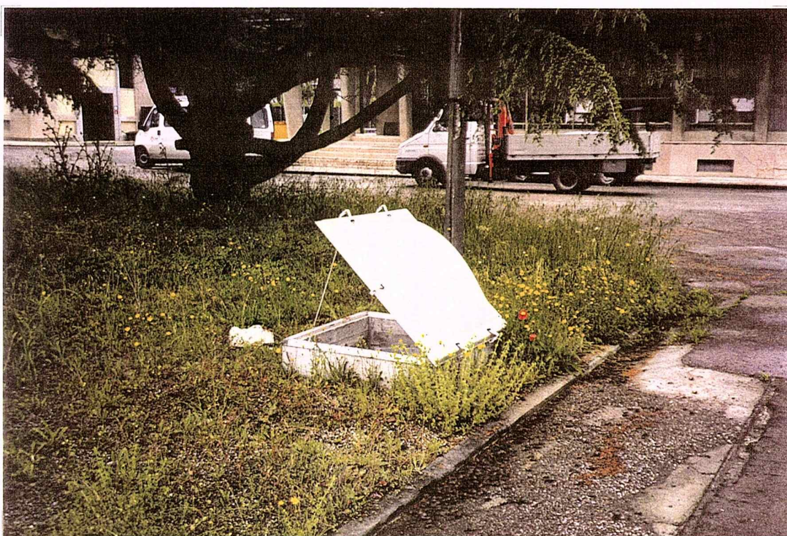
PASSO D'UOMO TIPO - Dimensioni 1,10 x 1,10 x 0,25 h.
