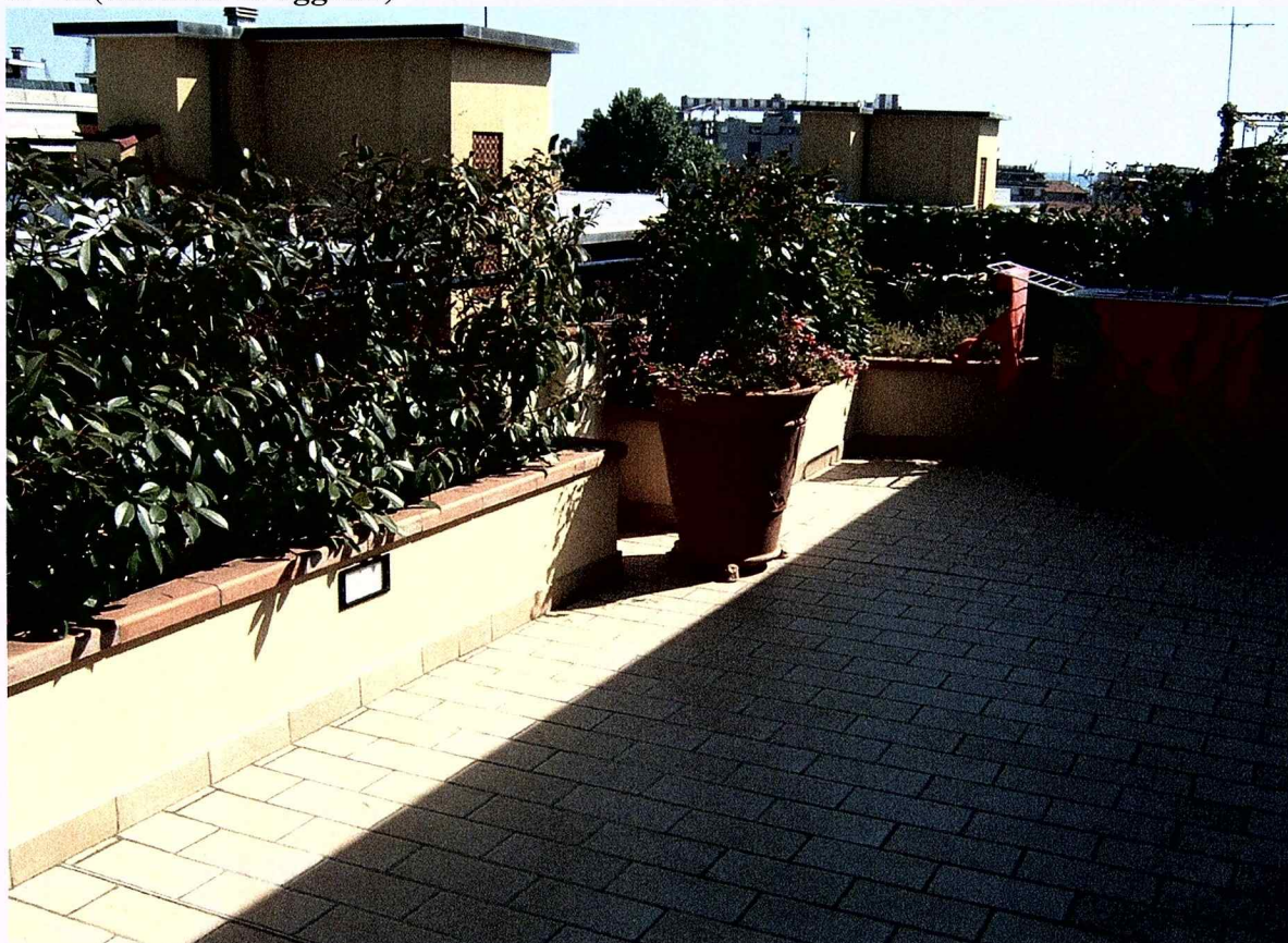
FOTO N° 12(terrazza in oggetto)
