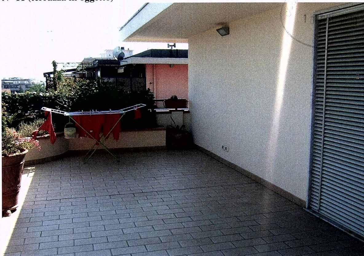
FOTO N° 11 (terrazza in oggetto)
