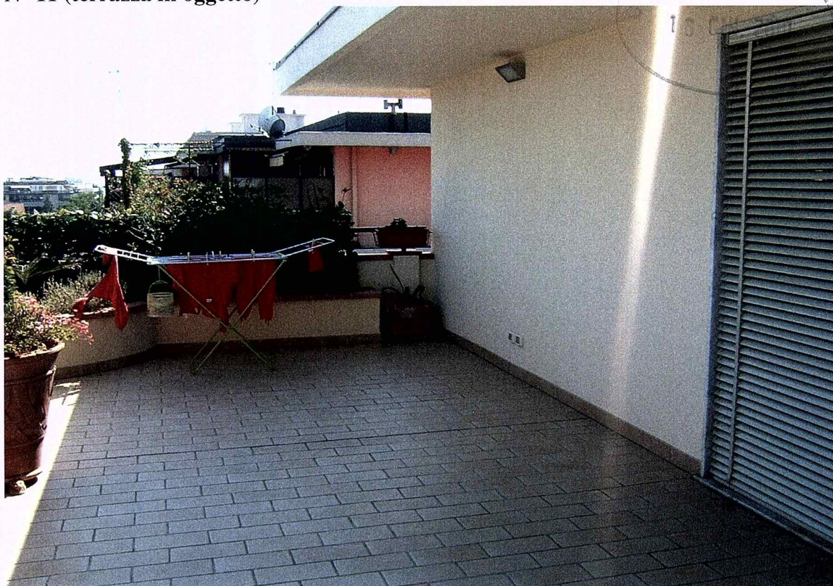
FOTO N° 11 (terrazza in oggetto)
