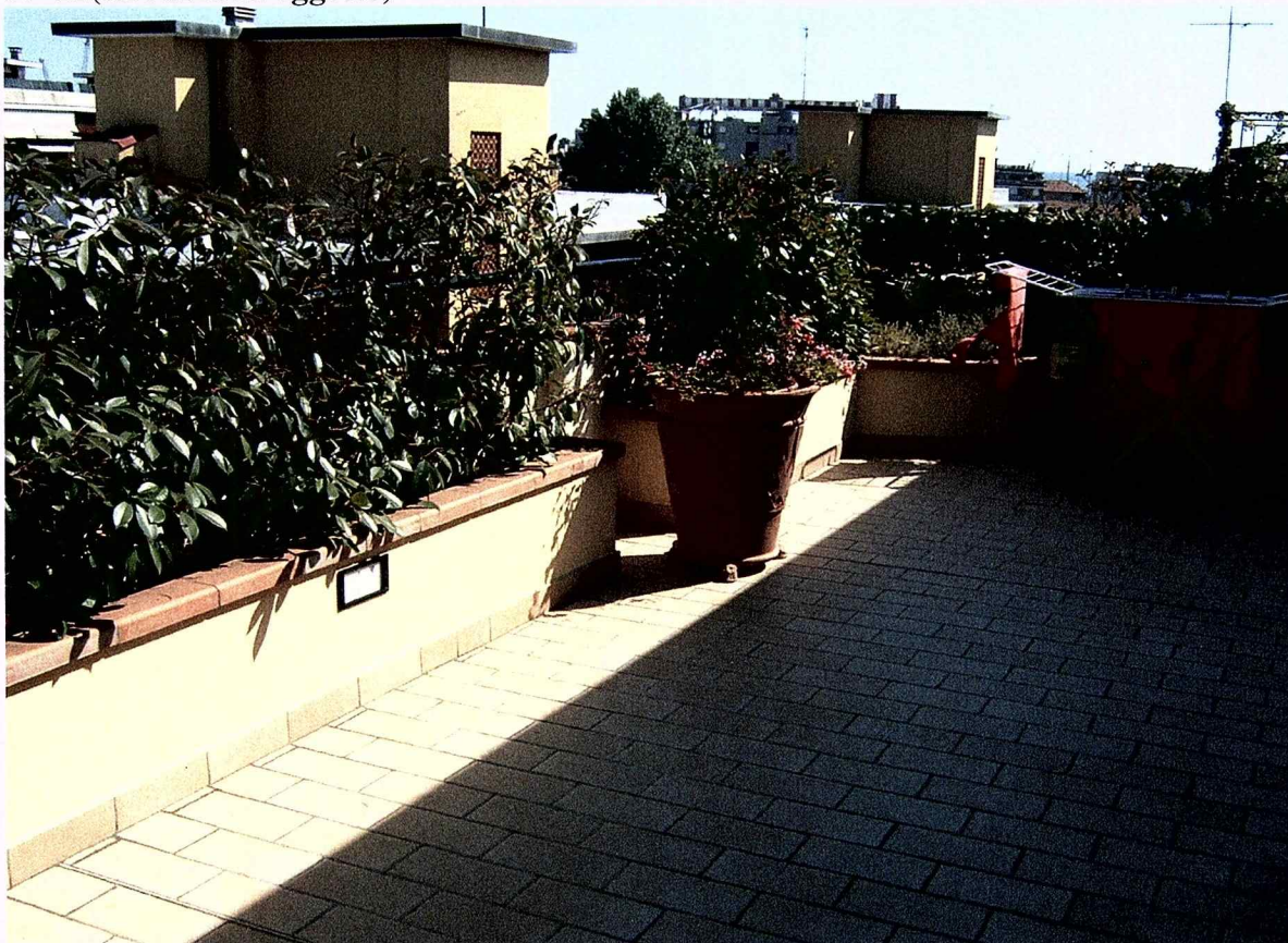
FOTO N° 12(terrazza in oggetto)
