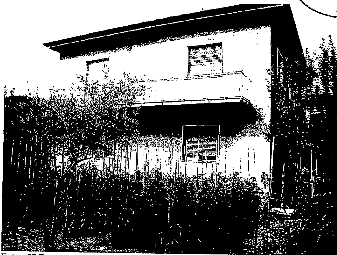
Foto n°2 Prospetto Sud fabbricato da demolire
