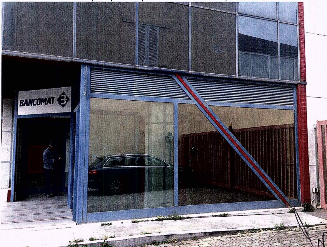
FOTO 1. Sostituzione del serramento di ingresso all'Agenzia con nuovo di diversa tipologia ma uguale colore del precedente ed allargamento della rampa per portarla a mt. 1,20 per migliorare l'accesso all'Agenzia da parte dei disabili e realizzazione di parapetto a protezione della rampa stessa.
