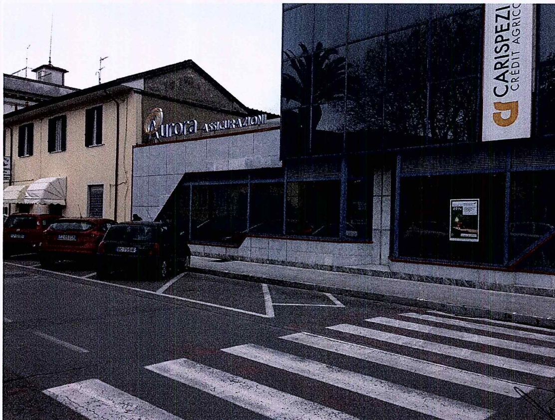
FOTO 6. Prospetto Sud – Fronte su C.so Garibaldi - Pulizia dei serramenti esterni
