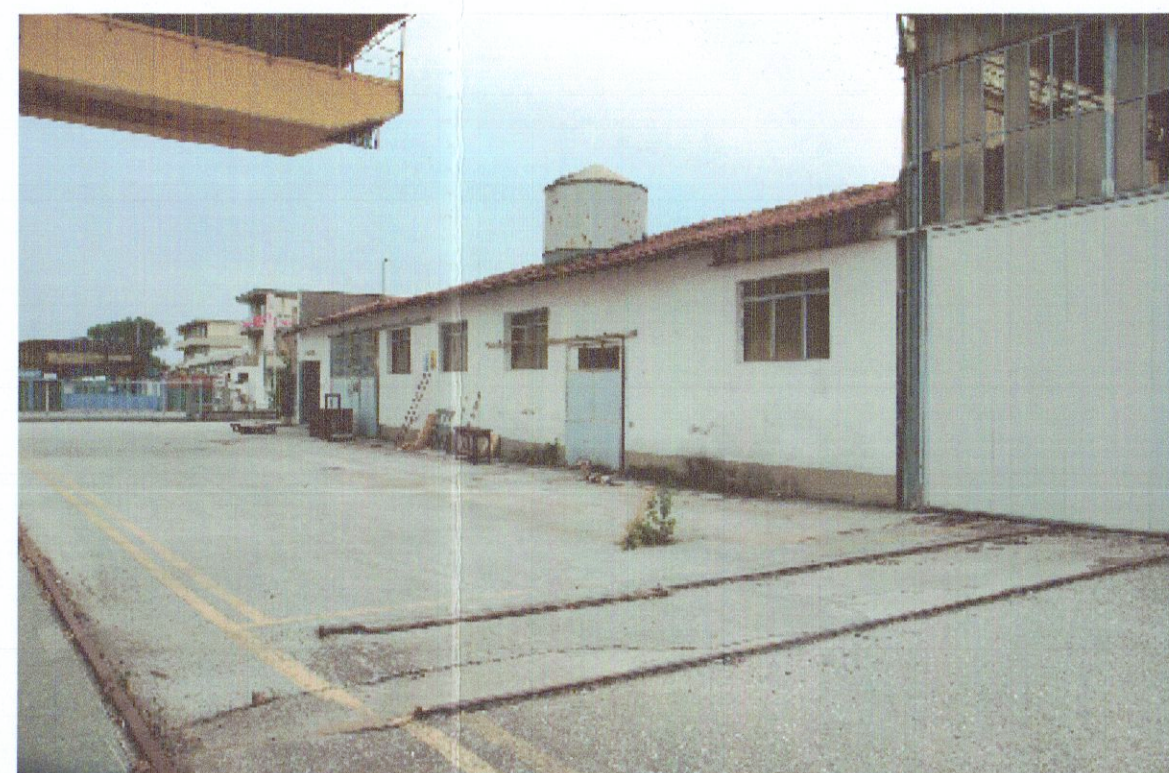
prospetto lato nord (foto n°1)
