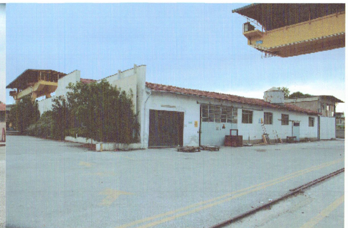
prospetto lato est (foto n° 3)
