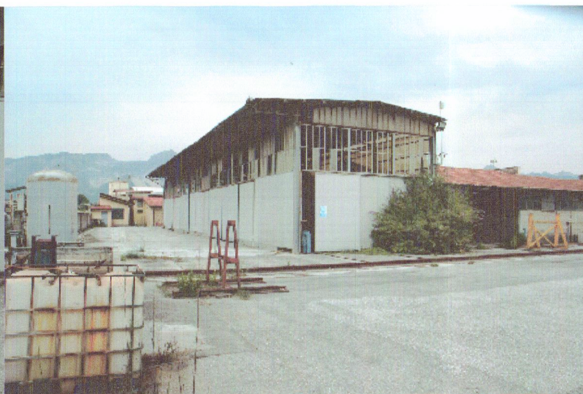
prospetto lato ovest (foto n°2)
