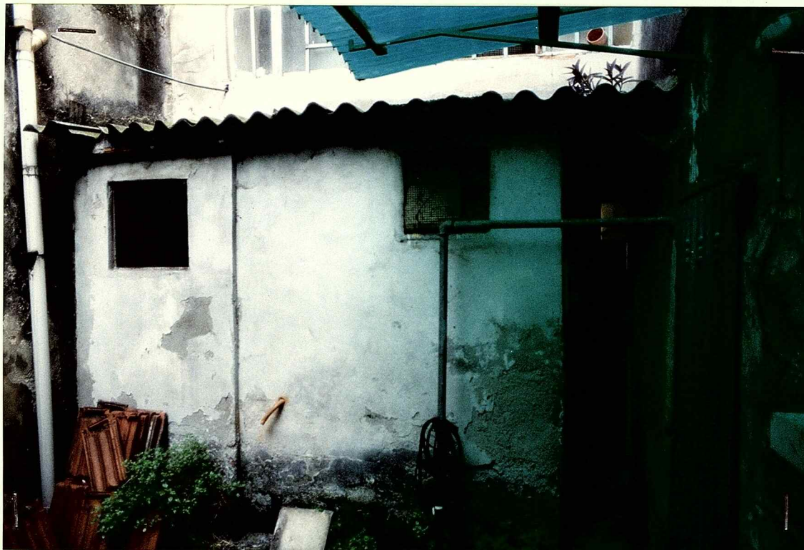
SERVIZIO IGIENICO LATO CORTILE
