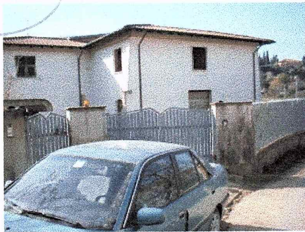
INGRESSO - PROSPETTO SU STRADA PRIVATA
