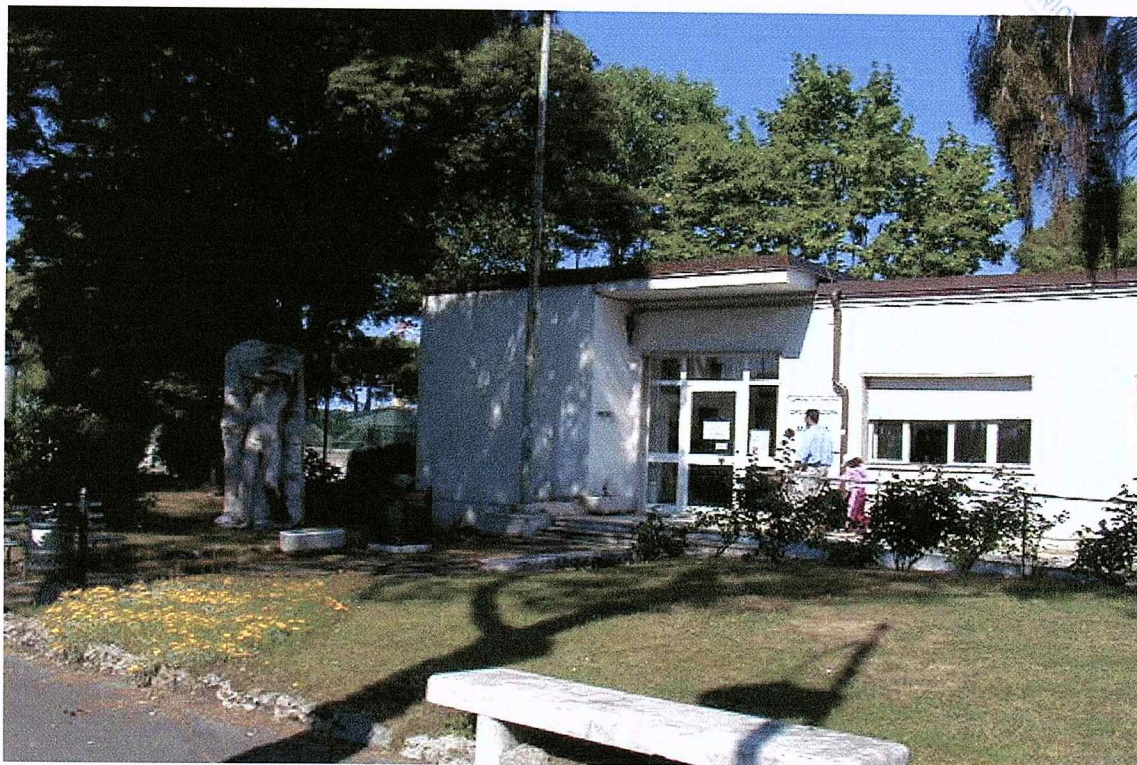
Vista da Viale XX Settembre
