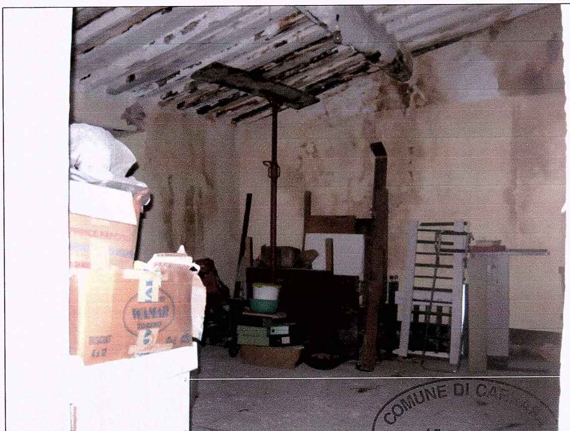
Foto n° 4 - Veduta interna angolo cucina
