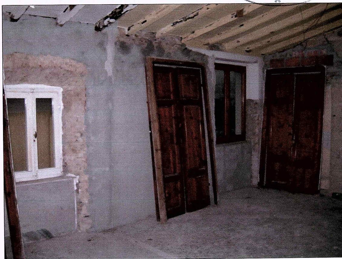
Foto n° 5 - veduta interna angolo soggiorno
