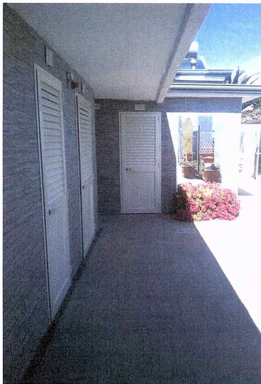
Foto 11/12/13 - Vista area servizi a levante
