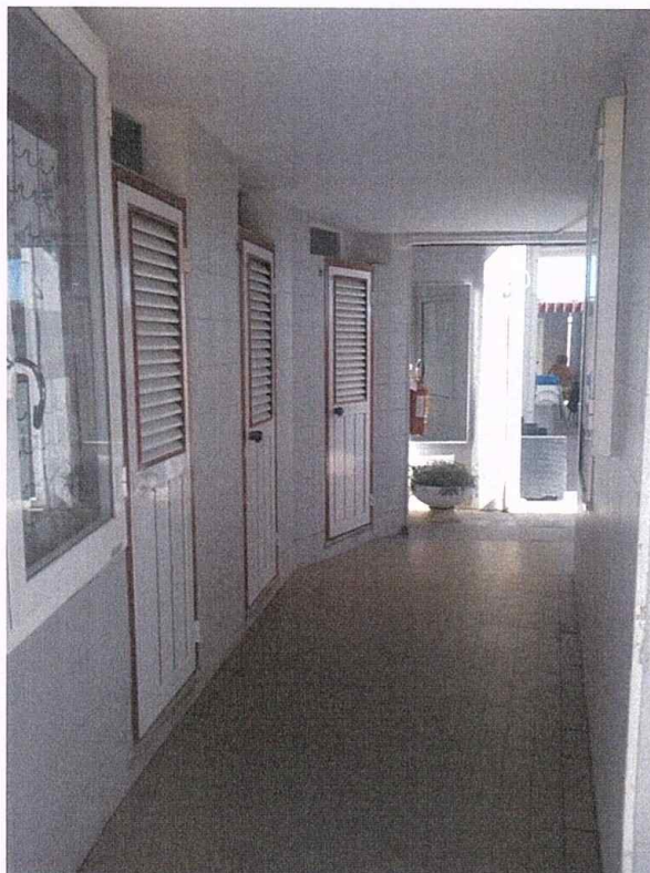
Foto 15 - Vista passaggio vagone di ponente
