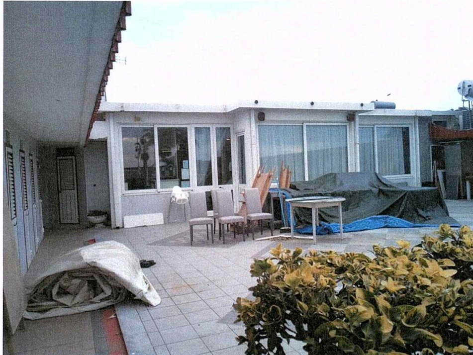
Foto 7 - Vista edificio di testata lato interno
