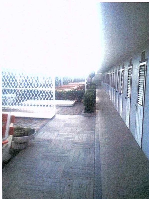
Foto 19/20 - Vista corridoio di levante vagone cabina
