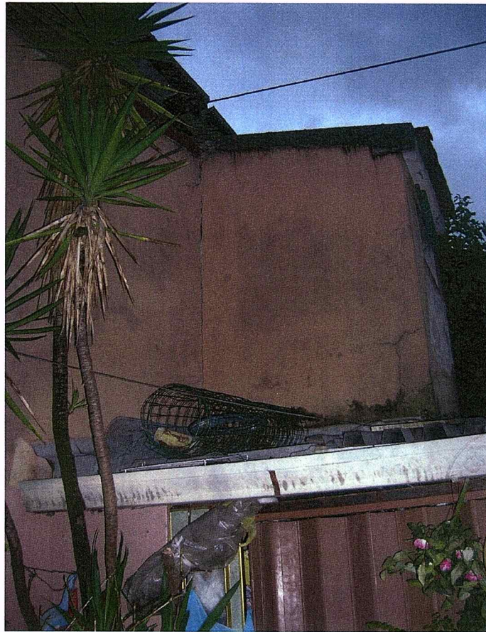
Foto 3: vista del bagno retrostante l'immobile, con particolare dello strappo nel giunto della muratura
