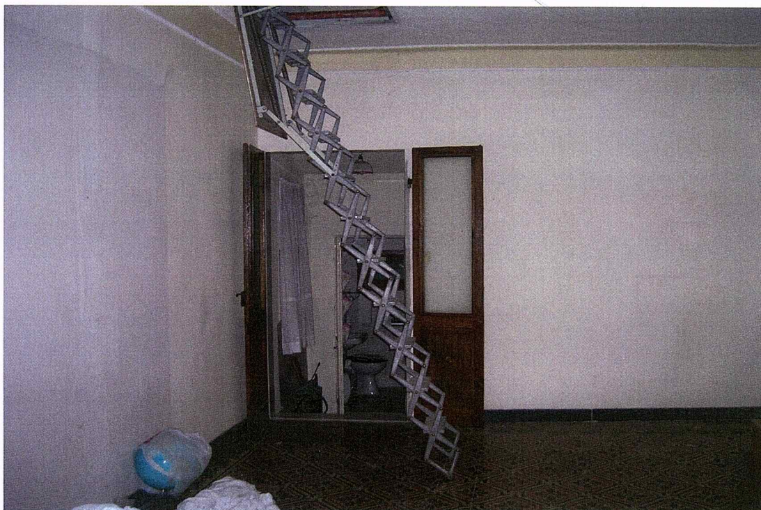
Foto 6: vista del piano primo con scala retrattile di accesso al locale sottotetto.
