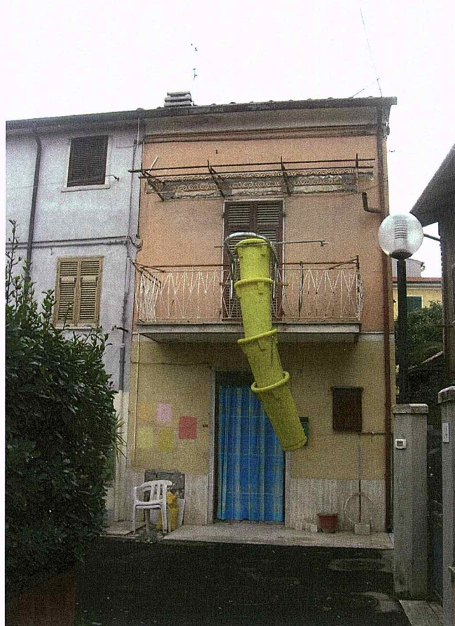
Foto 1: prospetto principale del fabbricato
