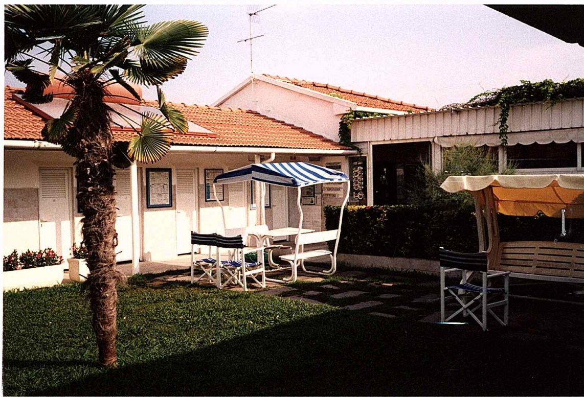
Documentazione fotografica Bagno Excelsior Marina di Carrara. Foto 3-4
