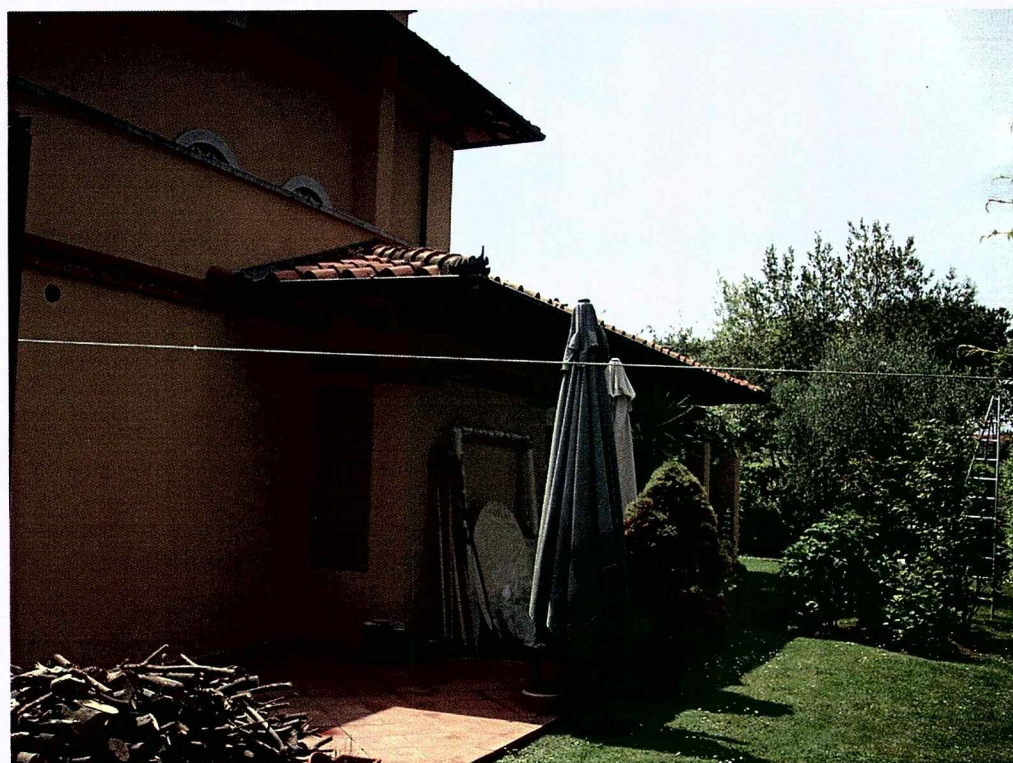
Foto n° 24: Vista lato La Spezia verso mare
