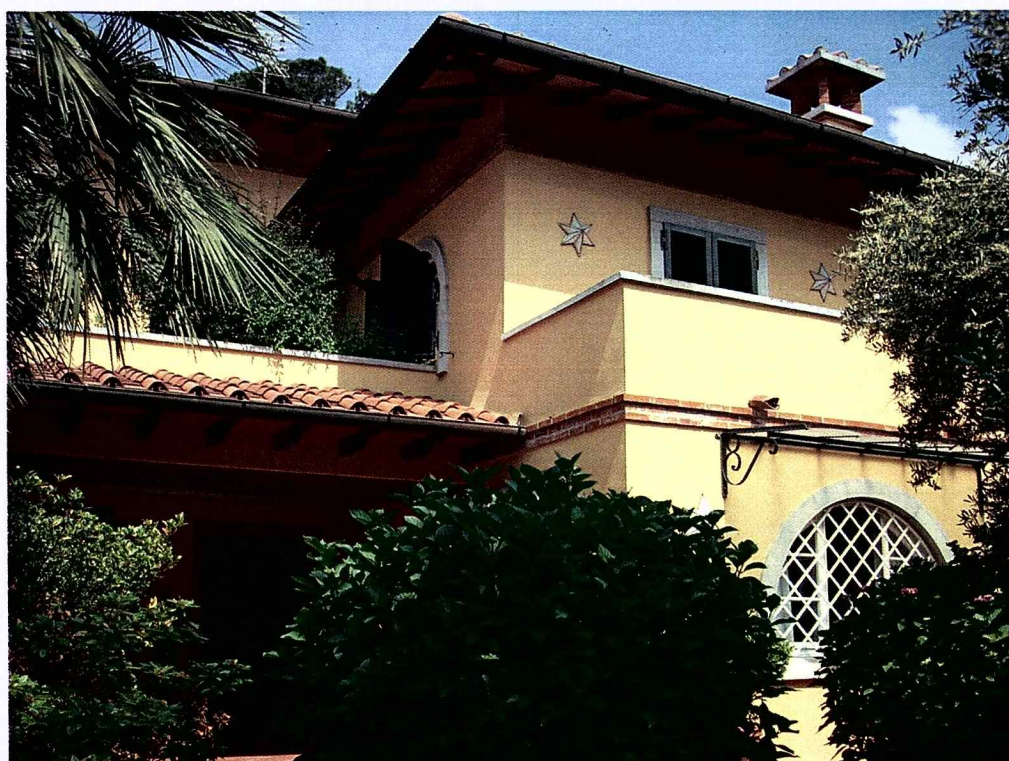
Foto n° 16: Vista lato Viareggio
