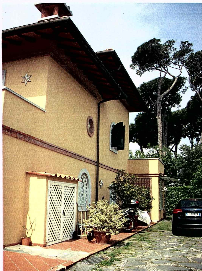
Foto n° 18: Vista lato monti verso La Spezia
