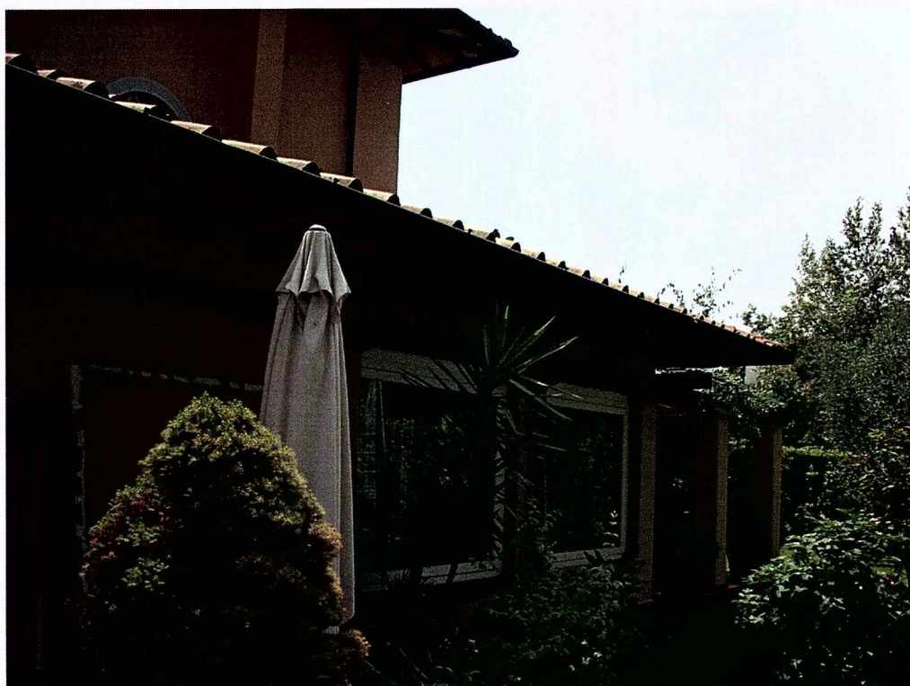
Foto n° 25: Vista lato La Spezia verso mare
