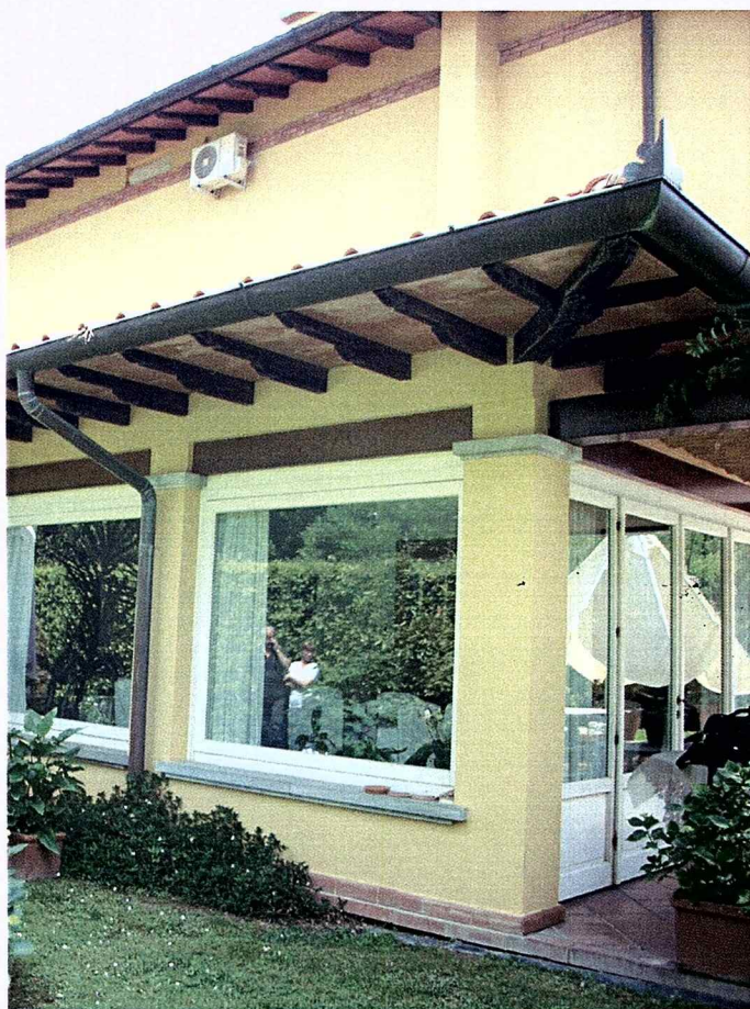
Foto n° 11: Vista angolo mare-La Spezia
