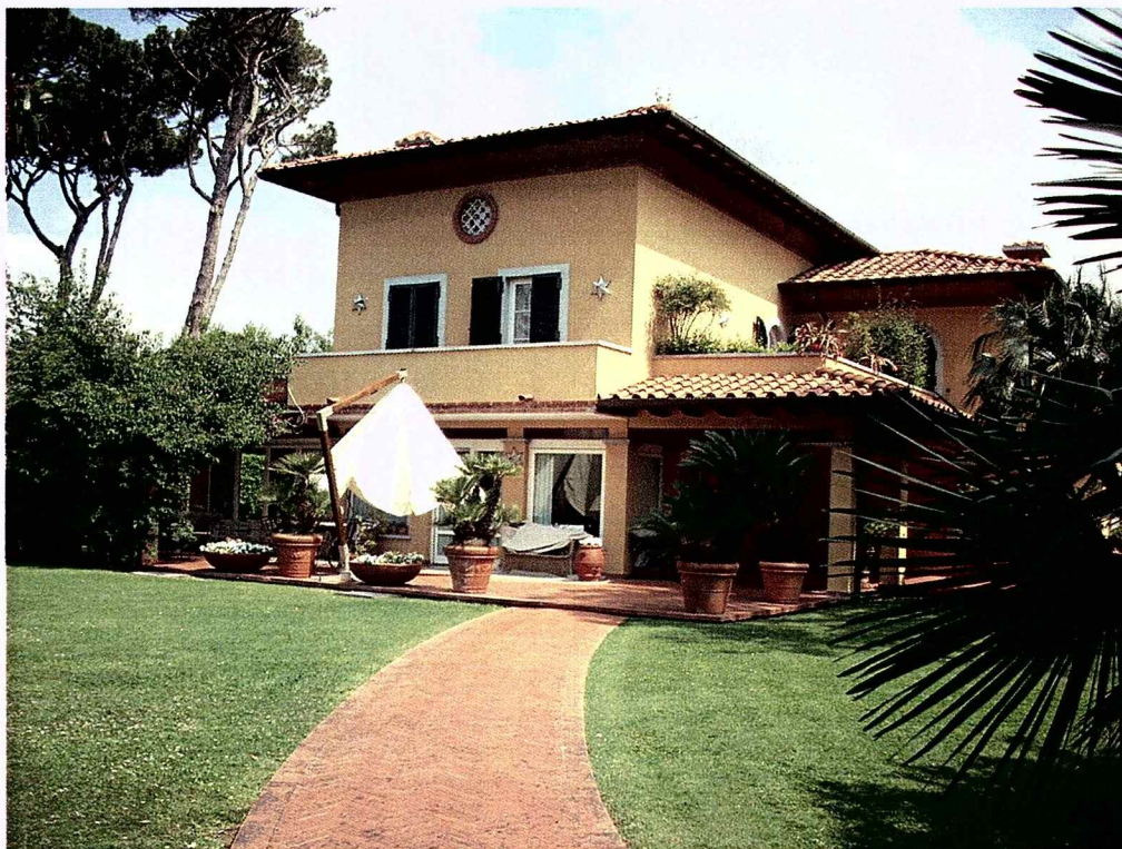
Foto n° 7: Vista lato mare dall'ingresso pedonale
