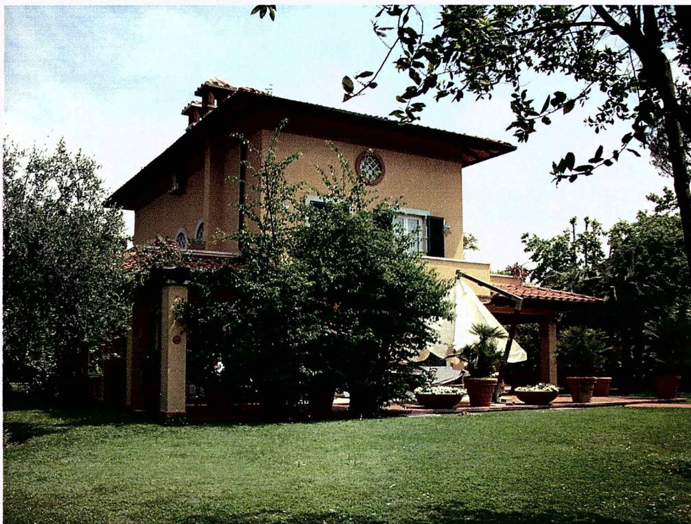
Foto n° 9: Vista angolo mare-La Spezia
