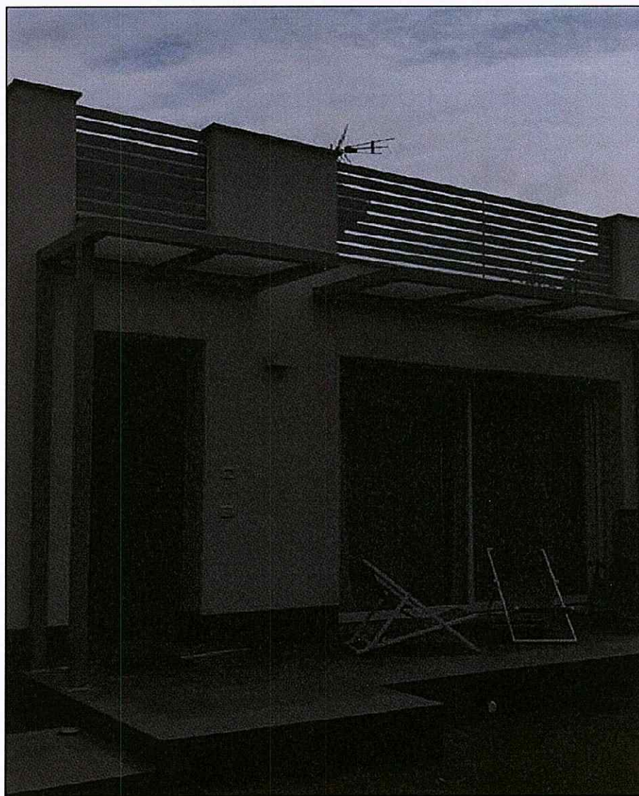
Foto n°2 - Prospetto sud ovest
