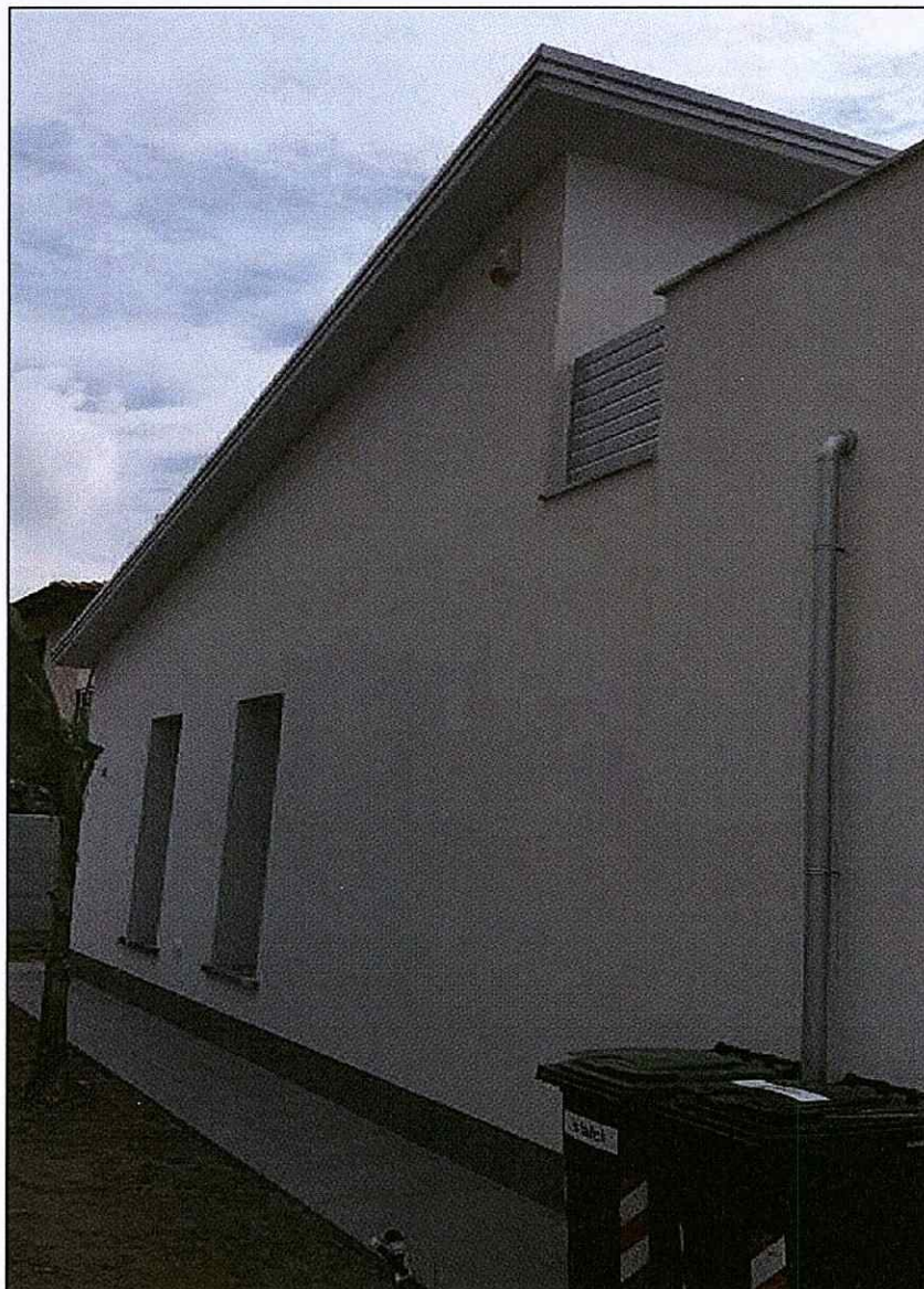
Foto n°6 - Prospetto nord ovest
