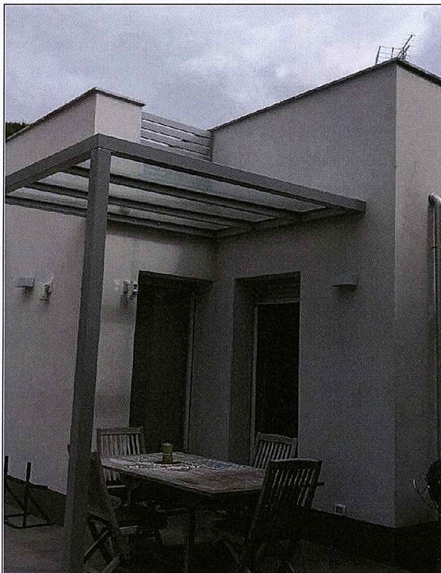
Foto n°3 - Prospetto sud ovest - sud est
