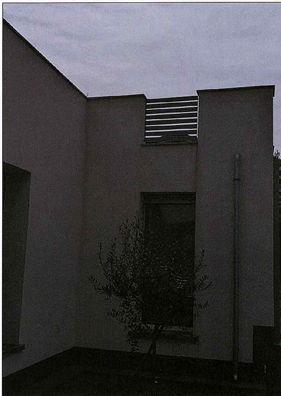
Foto n°4 - Prospetto nord ovest
