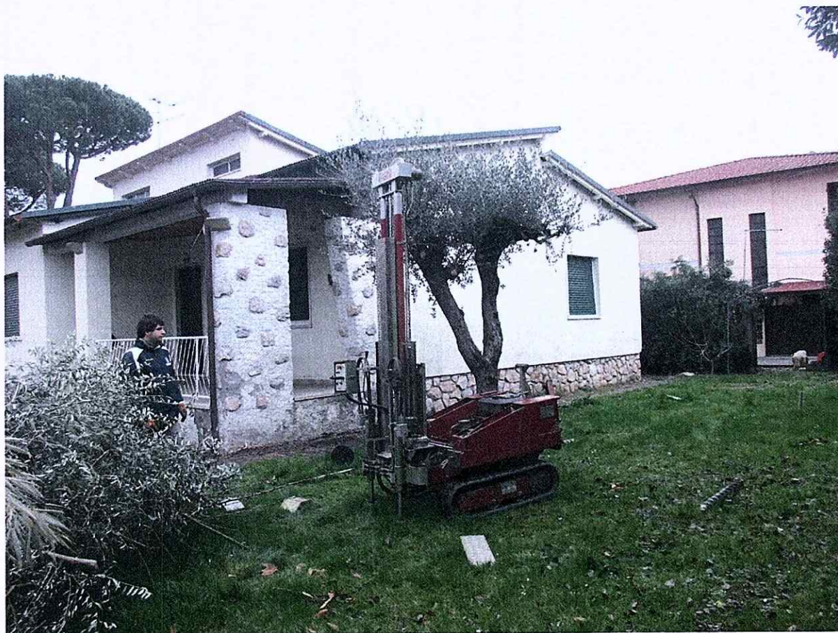
Foto 1 Prova penetrometrica dinamica superpesante eseguita nell'area in cui verrà realizzato l'ampliamento all'edificio principale.
