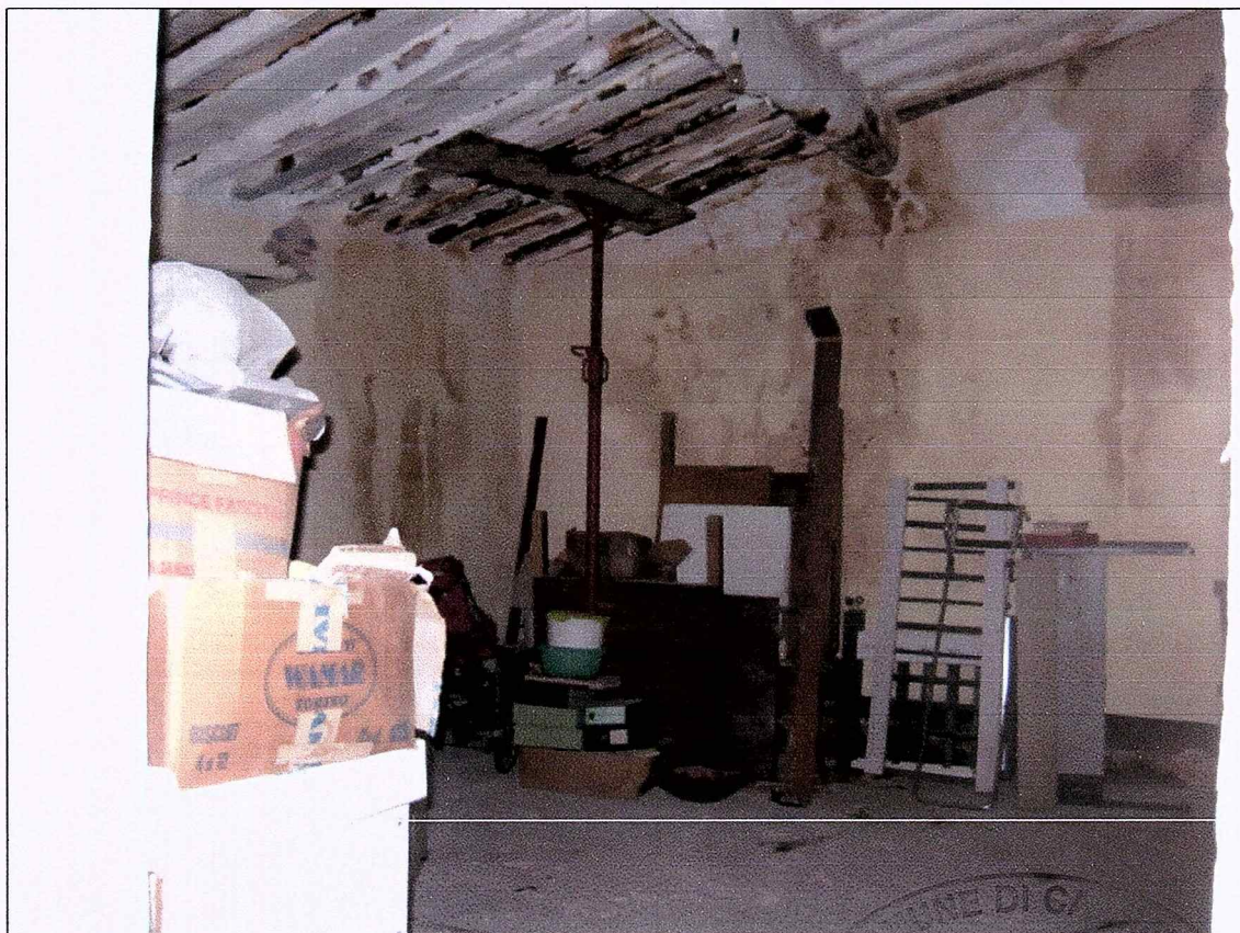
Foto n° 4 - Veduta interna angolo cucina
