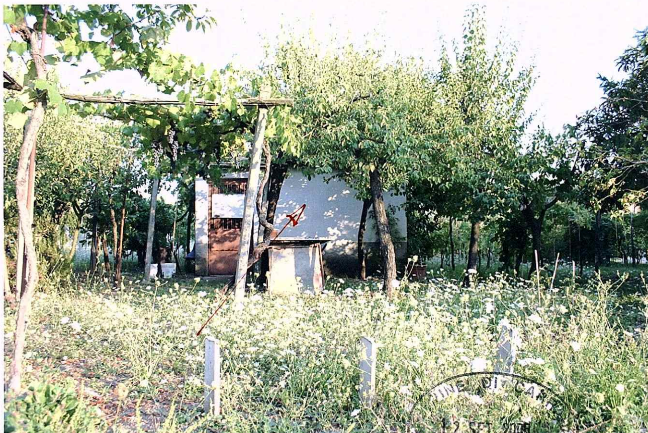
FABBRICATO A da demolire
