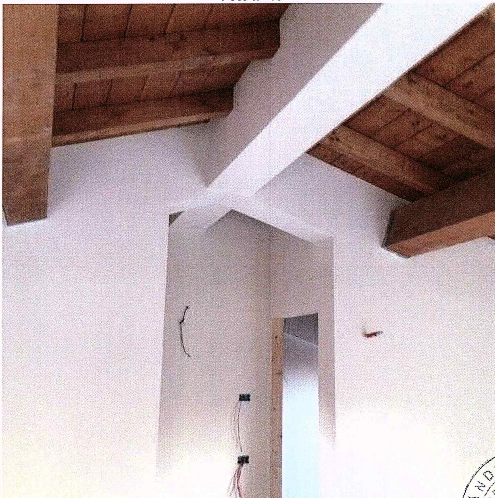
La trave di colmo in c.a. del piano sottotetto
