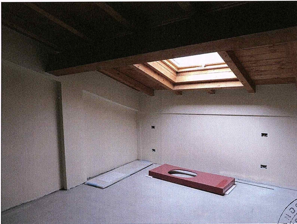
La struttura portante in c.a. del piano sottotetto, e la copertura in legno.
