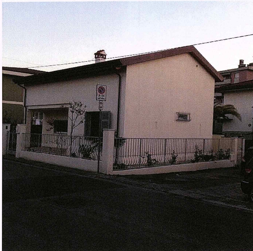
La facciata verso Sarzana
