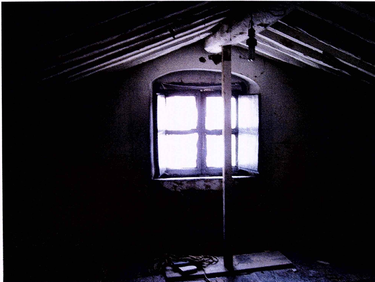
Foto 3 – Vista della soffitta.
