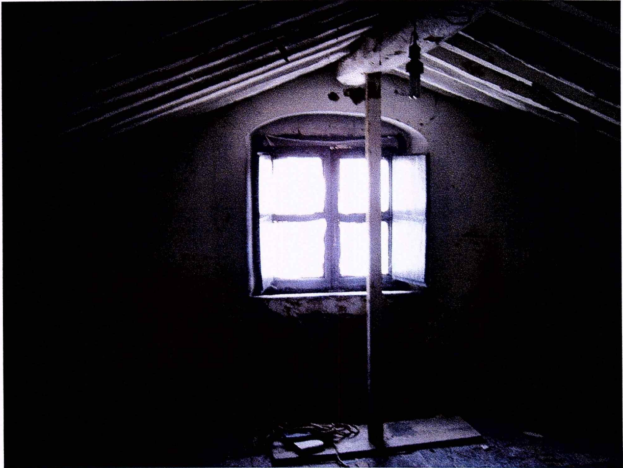
Foto 3 – Vista della soffitta.
