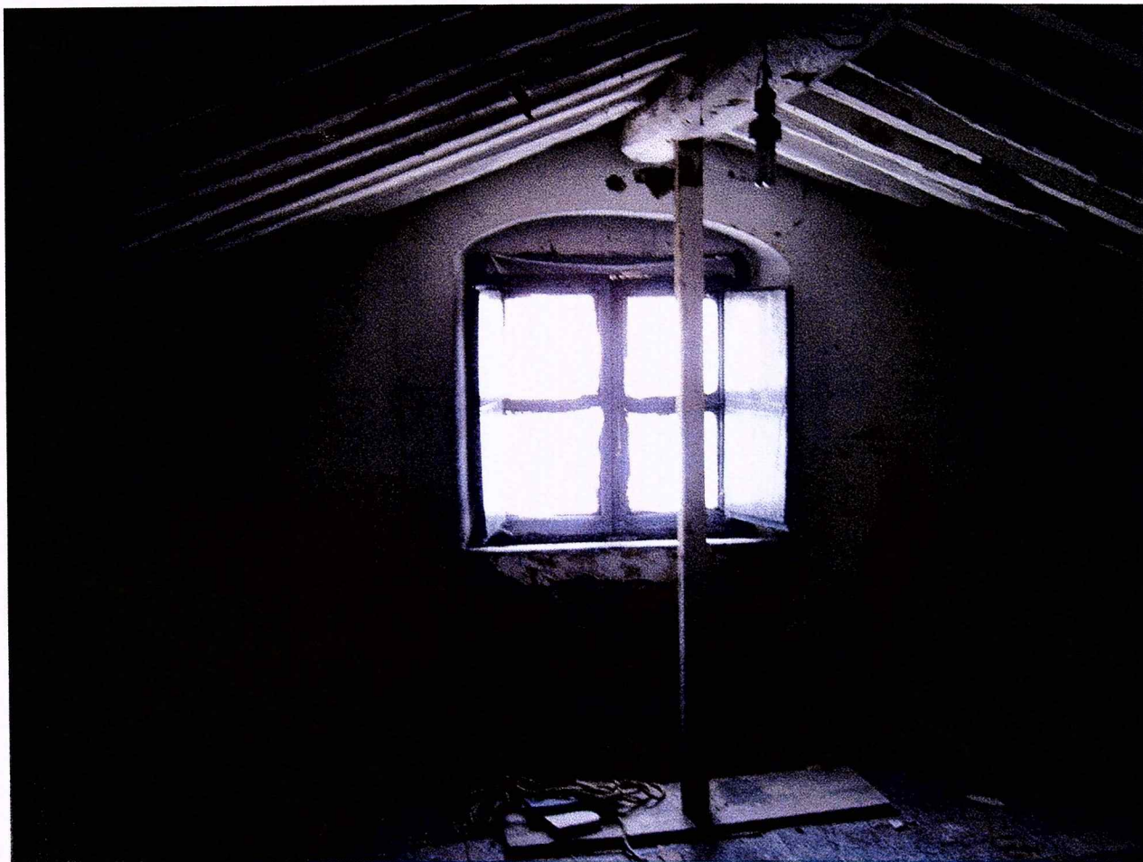
Foto 3 – Vista della soffitta.
