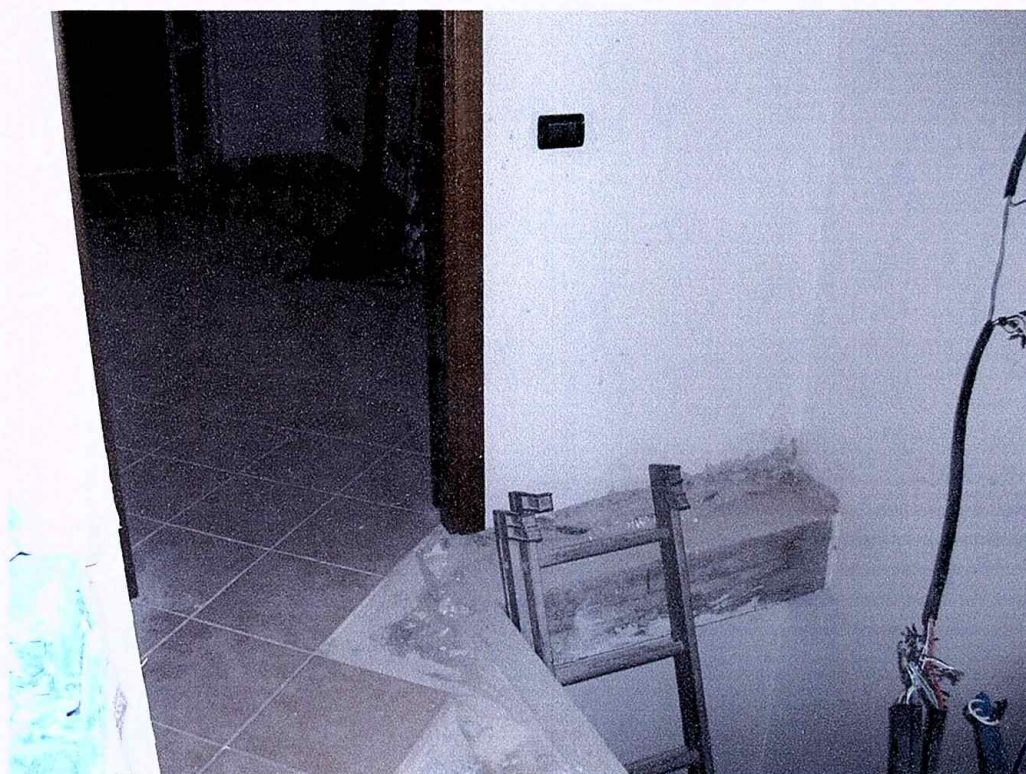
Foto 6- Vano scala piano secondo
