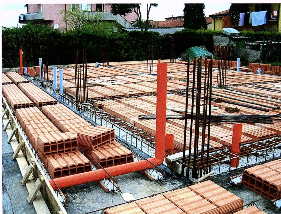
Solaio Piano Terra
