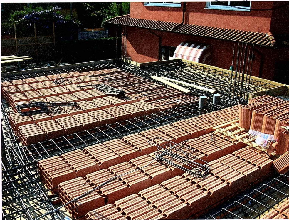
Solaio Piano Primo
