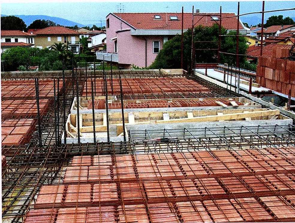
Solaio Piano Primo
