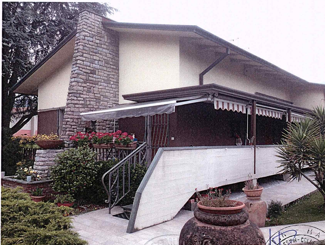
Foto n° 1 – Vista dell'esterno del fabbricato: lato Via Provinciale
