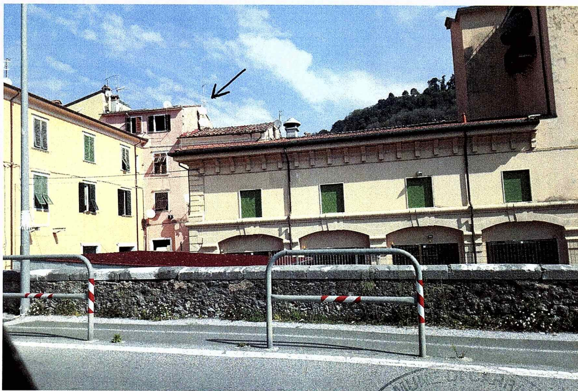
ESTERNA LATO MARE
