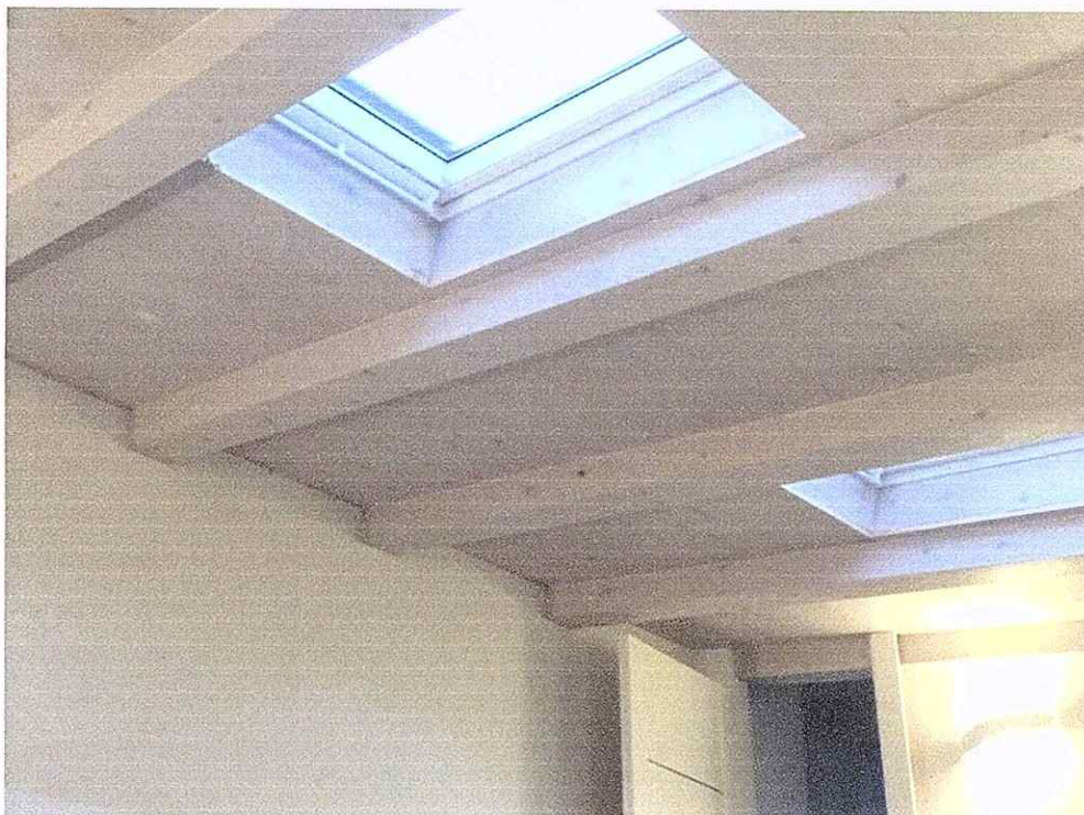
11 e 12 – Scorci del monolocale da cui è possibile vedere la luce in mattoni di vetro-cemento ed il solaio di copertura con rivestimento ligneo e lucernari.
