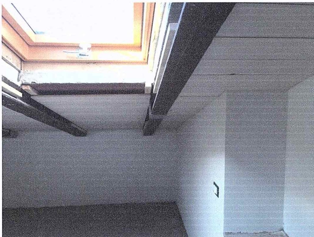
4 – Scorcio del locale sottotetto da cui è possibile individuare il lucernario d'accesso in copertura ed il sistema di fissaggio del punto di ancoraggio sul travetto prefabbricato di calcestruzzo.
