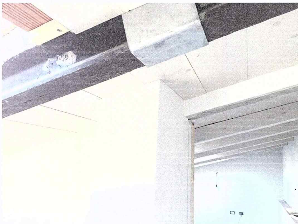
5 – Scorcio di dettaglio del locale sottotetto verso il doppio volume del monolocale da cui è possibile cogliere il sistema di fissaggio del punto di ancoraggio sul travetto prefabbricato di calcestruzzo.
