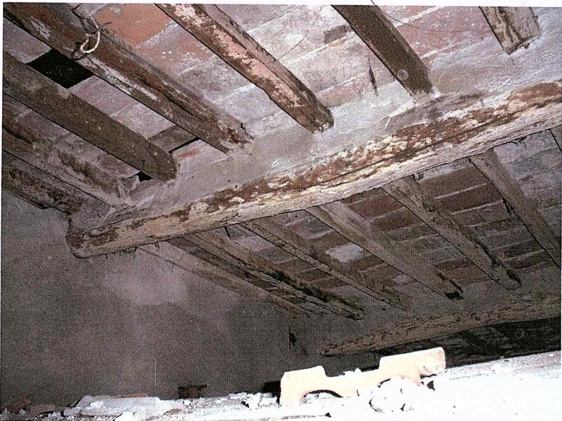
Foto 23 - Sottotetto (Tetto originario travi e travetti in castagno con pianelle in cotto)
