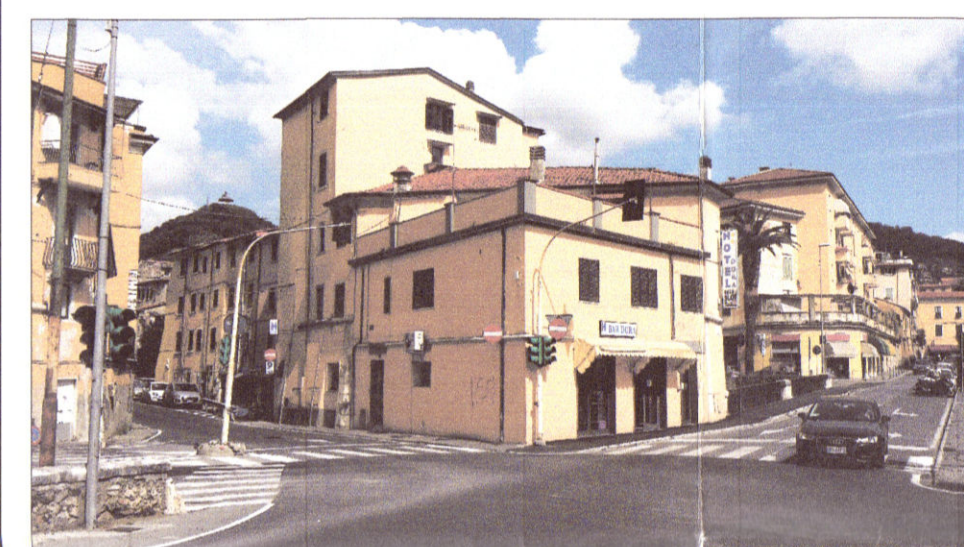
FOTO 2 VIA APUANA VIA CARRIONA
