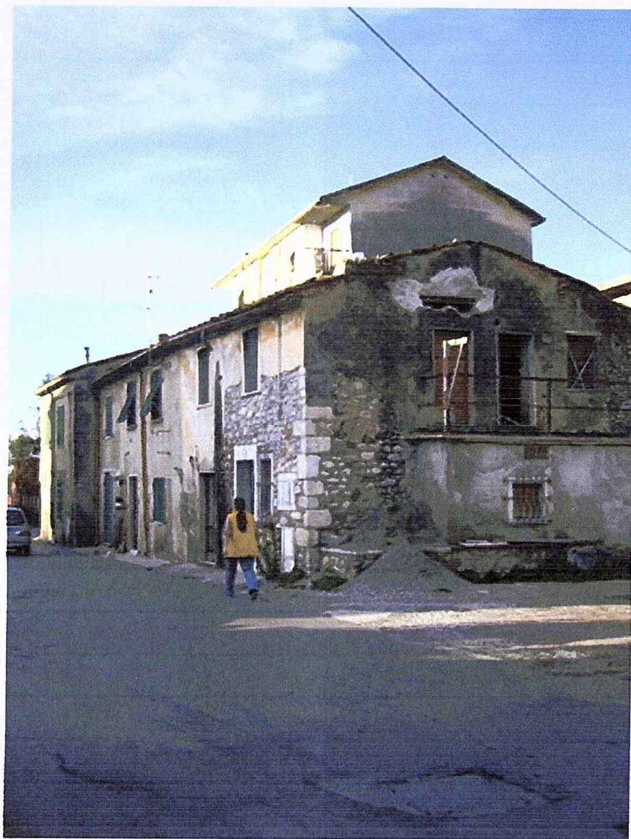
Foto n° 5 Fabbricati L. 1770/1 Lato Carr
