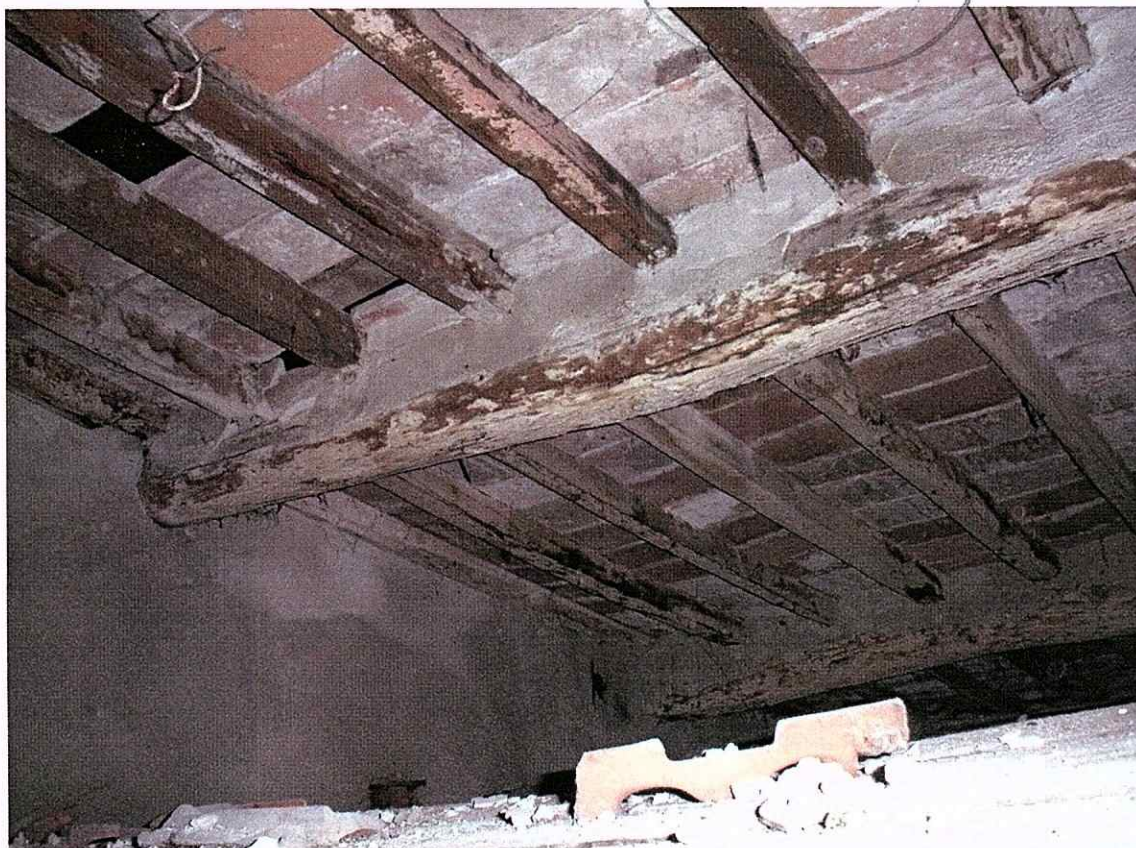
Foto 23 - Sottotetto (Tetto originario travi e travetti in castagno con pannelle in cotto)
