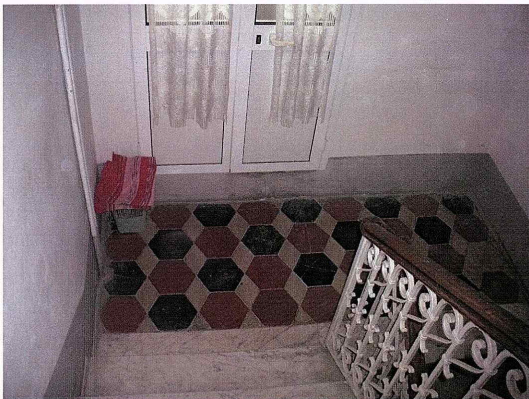
Foto 4 - Pianerottolo mezzanino in comune, ingresso W.C.
