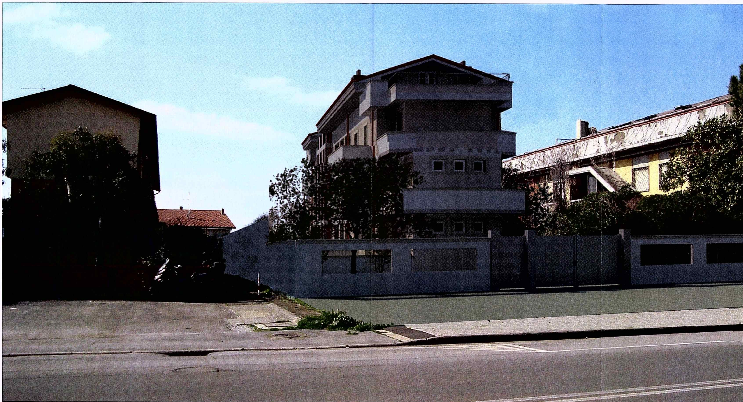
Vista lato Via delle Pinete
