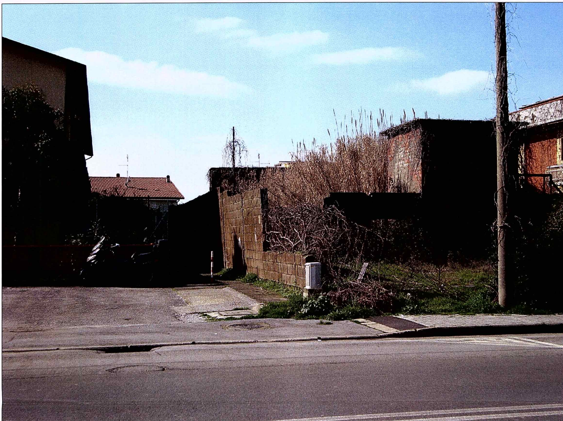
Vista lato Via delle Pinete
