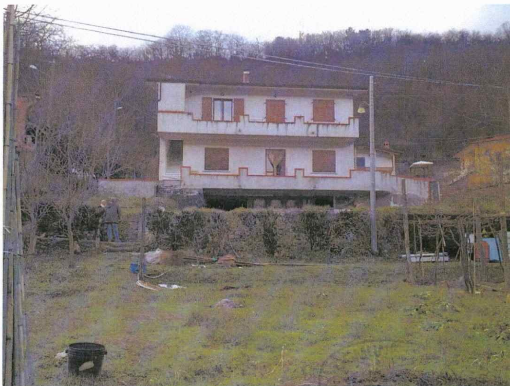
Foto1 – Visione panoramica corrispondente al prospetto est.
