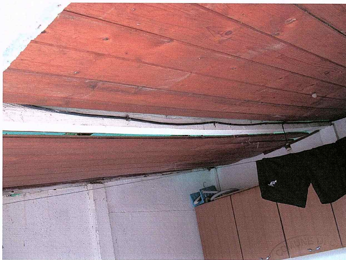
COPERTURA LOC. ACCESSORIO STRUTTURA INTERNA
