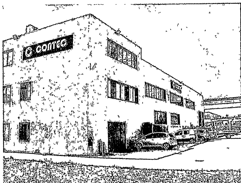
Foto 2 - Vista d'angolo facciata Nord Est e Sud Est
