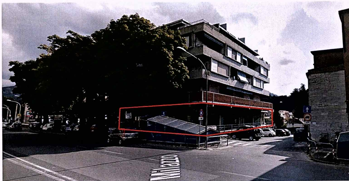
Foto n. 01 – Individuazione piano oggetto di intervento
