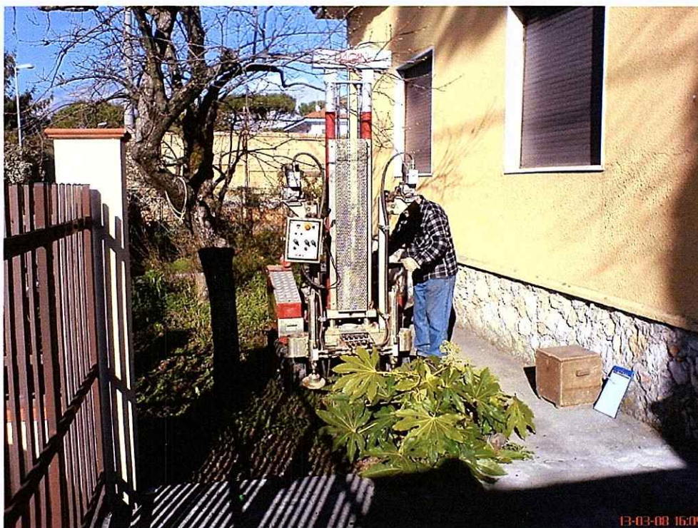
Foto n°2 – Prova penetrometrica statica CPT2 lungo prospetto NO (lato La Spezia)
