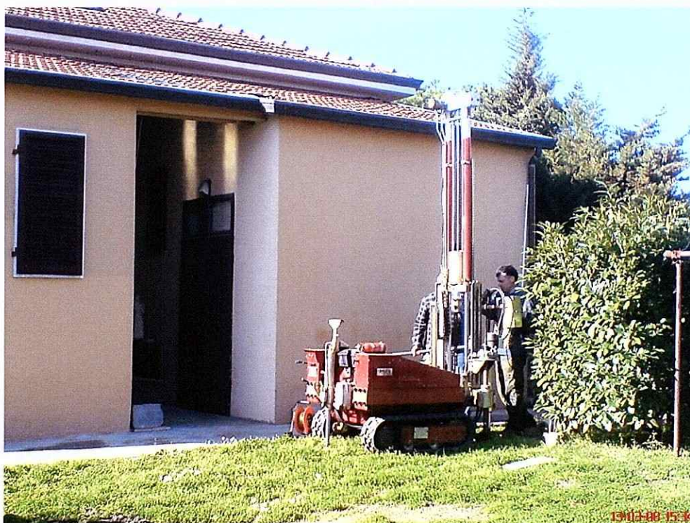
Foto n°1 – Prova penetrometrica statica CPT1 lungo prospetto SE (lato Versilia)
